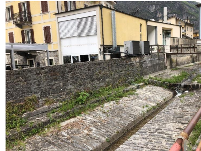
Riale Dragone nella zona di via Nadro/Piazza Nosetto, vista verso monte
