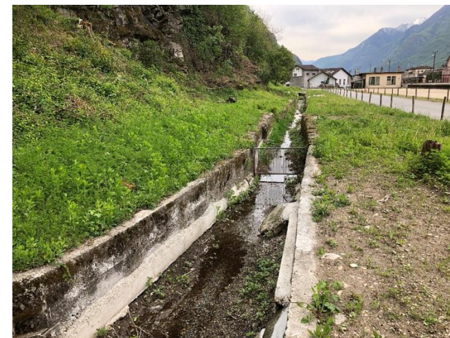
Il riale Moterell raccoglie le acque di scolo dal versante retrostante la stazione FFS di Biasca
