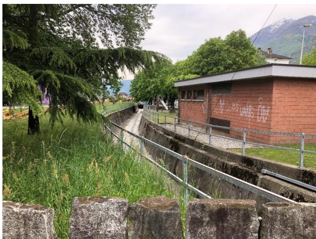
Riale Dragone, zona Parco Emma, lungo i binari delle officine FFS. Vista verso valle
