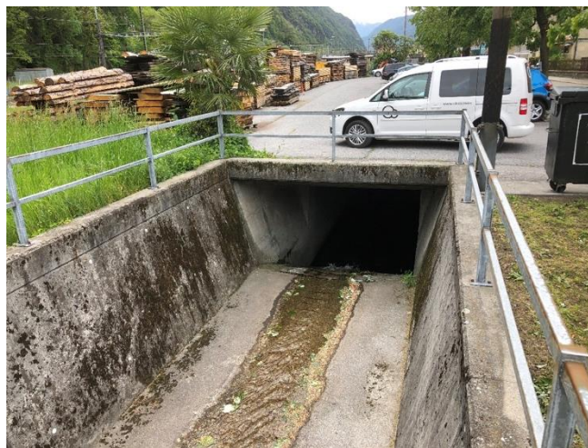
Riale Dragone, inizio del tratto intubato presso la stazione FFS
