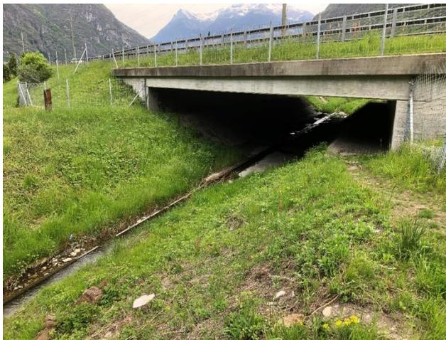
Sottopasso autostrada N2, vista verso monte. Adeguamento banchine laterali, schermatura con ripari, realizzazione di siepi e boschetti
