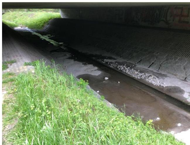
Sottopasso strada A2, consolidamento del fondo e banchine laterali non ottimali, vista verso valle
