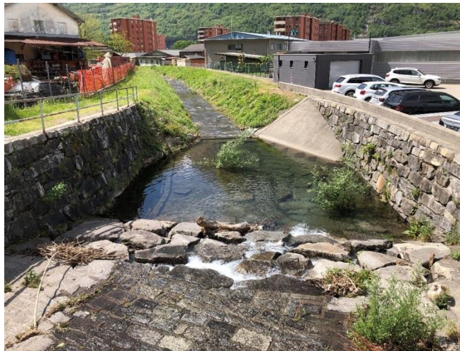
Salto di fondo a valle della cantonale e inizio del tratto con sezione trapezoidale consolidata con piattoni, vista verso valle
