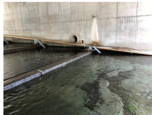
Sottopasso nuovi binari FFS, vasche unite da soglie in beton e rampe laterali in asfalto per la fauna terrestre
