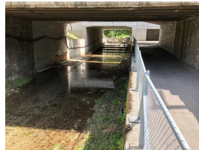
Sottopasso vecchi binari FFS, lastrico di consolidamento, presenza di banchine laterali asciutte e rinverdite (funzionali per la fauna), vista verso monte
