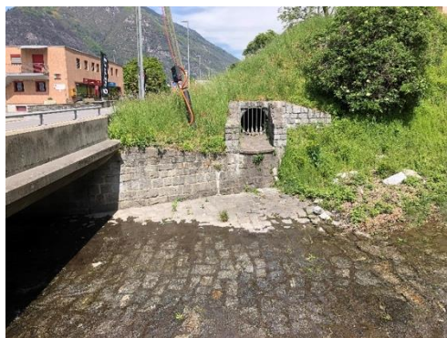
Alveo del riale e ingresso del sottopasso strada cantonale visto da monte, attualmente privo di banchina per passaggio faunistico
