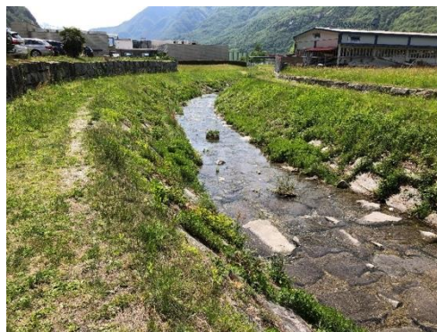
Riale Froda, tratto a regime temporaneo, intervento C
