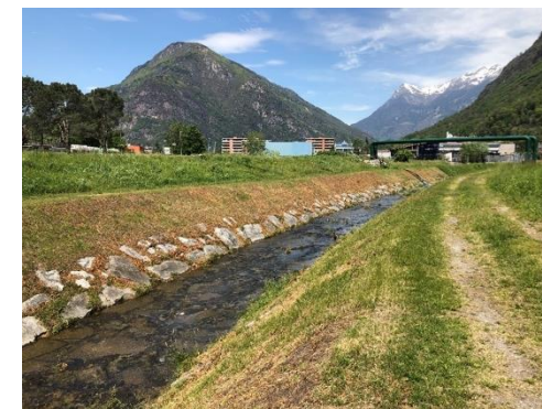
Riale Froda, tratto a regime perenne, intervento D con rivitalizzazione completa e via d'acqua
