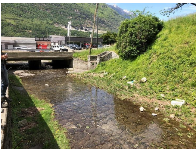
Tratto di riale tra i sottopassi FFS e la strada cantonale, immissione in sponda destra di uno scaricatore fognario
