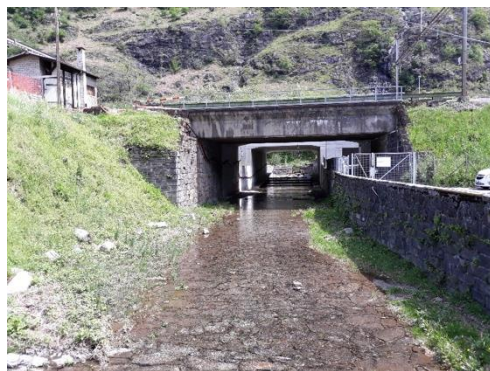
Sottopassi binari FFS visti da valle; qui è prevista la posa di siepi e strutture di invito alla fauna
