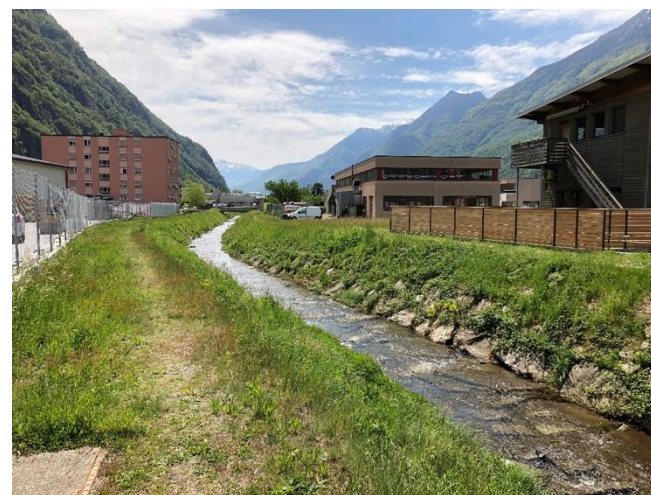
Sezione trapezoidale consolidata nella zona urbana e industriale. La sezione è costante fino alla confluenza con il riale Aldirei (tratto più a valle già rinaturato)
