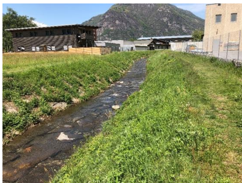
Riale Froda, tratto a regime temporaneo, intervento C
