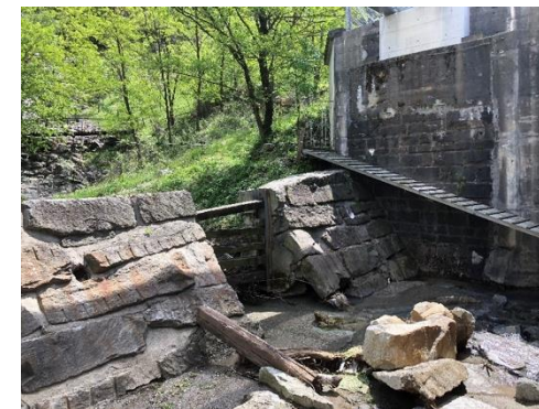
Briglia/ostacolo in uscita verso monte dal sottopasso; il passaggio laterale sulla rampa in legno è impedito da un cancello posato successivamente
