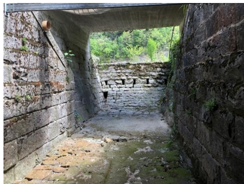
Sottopasso FFS e briglia della camera di ritenuta presente a monte della linea ferroviaria
