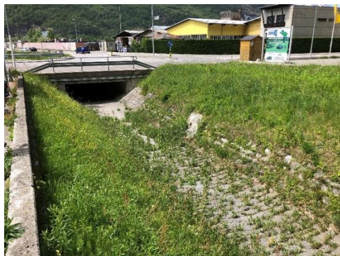
Alveo asciutto del riale e sottopasso strada cantonale visto da monte
