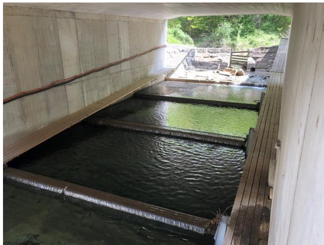
Nuovo sottopasso FFS, briglia e vasche artificiali con ostacoli in beton; connettività terrestre in parte risanata con banchine in assito; vista verso monte
