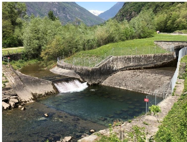
Dettaglio del punto di confluenza: si nota, nel momento dello scatto, la mancanza di portata in arrivo dalla centrale e il salto di fondo (scivolo lastricato) nel riale Froda, con altezza di ca. 1.80 metri
