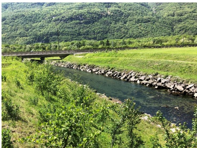
Vista dalla strada cantonale verso valle; in lontananza si osserva il nuovo viadotto della ferrovia ATG. L'alveo del corso d'acqua è fortemente modificato: rettificato, banalizzato e con arginature artificiali su entrambi i lati
