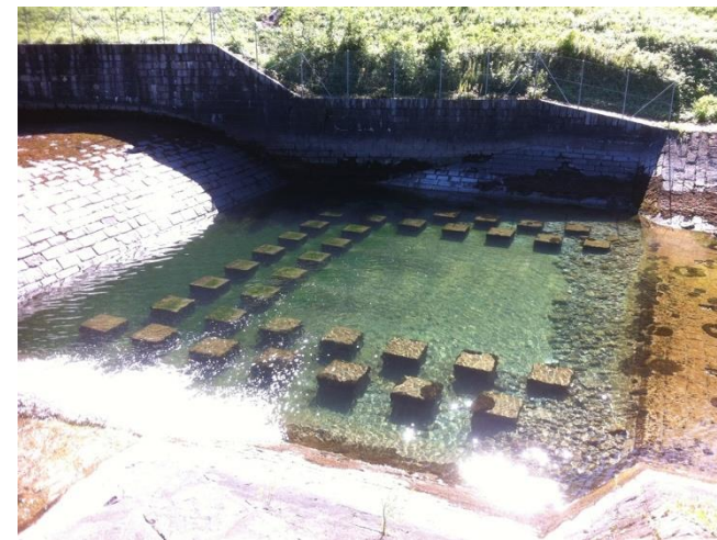
Particolare della vasca artificiale di scarico delle portate turbinare, con elementi per rottura dell'energia
