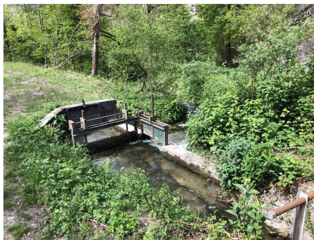
Opera di regolazione: a sinistra si deviano le acque irrigue verso Biasca, a destra le acque di scarico ritornano nel Brenno attraverso due tratti a cielo aperto e un tratto tombato
