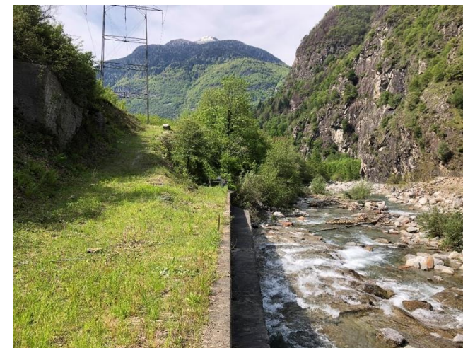
Opera di presa dei canali irrigui di Biasca sul Brenno, vista dalla sponda sinistra verso valle
