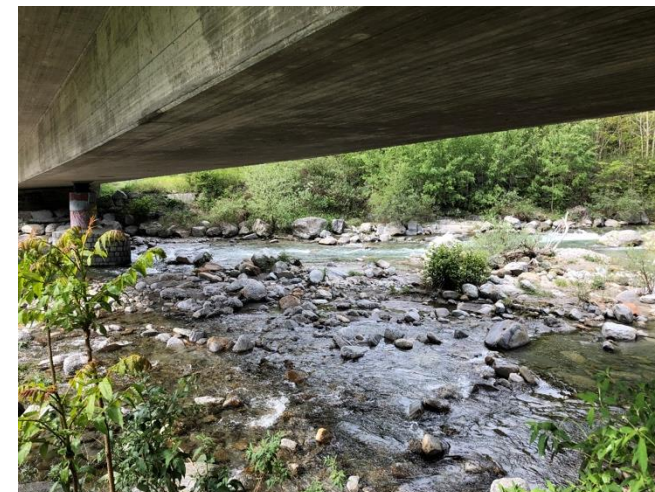
Fiume Brenno sotto il viadotto della cantonale della Valle di Blenio, vista dalla sponda sinistra verso monte
