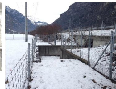
Sottopassi da adeguare: modifiche recinzioni, posa siepi e strutture di invito alla fauna, sgombero di ostacoli presenti
