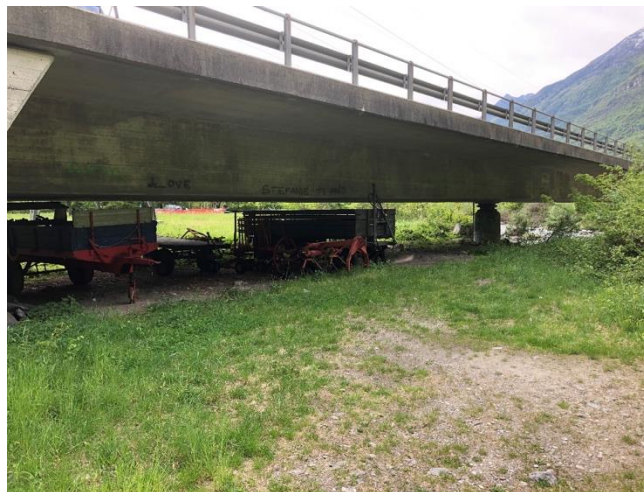
Deposito sotto il viadotto della strada cantonale della Valle di Blenio: costituisce un deficit per la funzionalità del corridoio faunistico sovregionale CO TI-09
