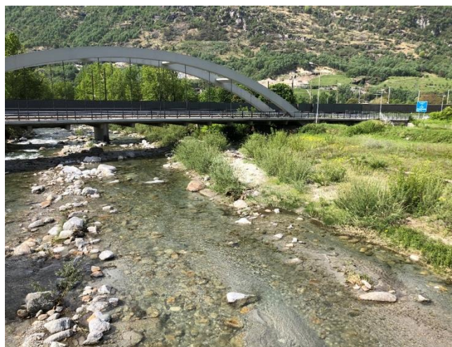
Vista dal ponte vecchio di Biasca, LFA sufficiente (ca. 45 ml) e spazio ripario funzionale, vista dal ponte vecchio verso valle (ponte strada cantonale)
