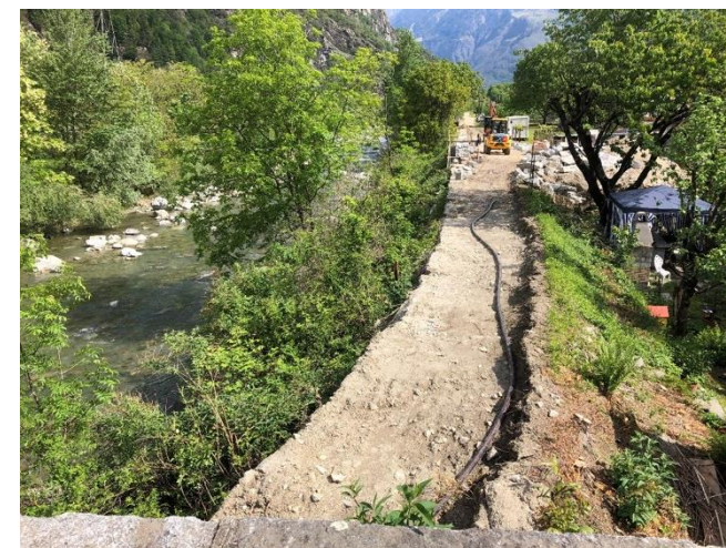
Lavori di innalzamento dell'argine in sponda sinistra a protezione della frazione di Ponte, vista verso monte dal ponte vecchio
