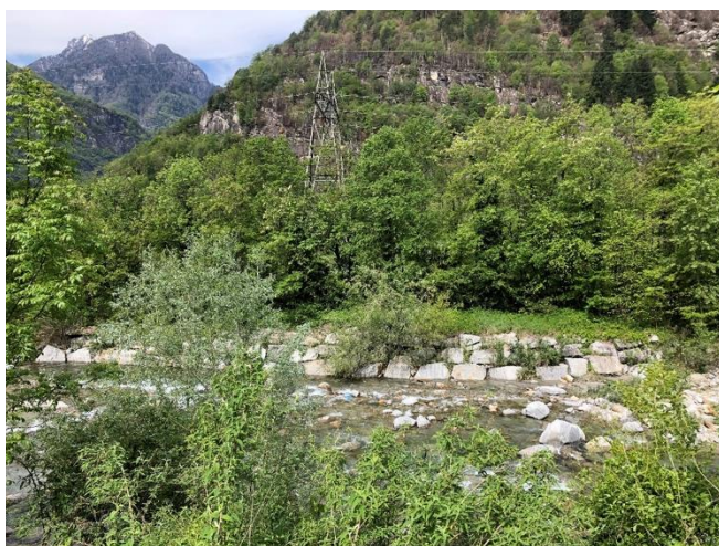
L'arginatura in sponda destra (tratto B) provoca un restringimento dell'alveo a 30 ml, deficitario rispetto alla larghezza naturale del fondo stimata (LnFA=48 ml)
