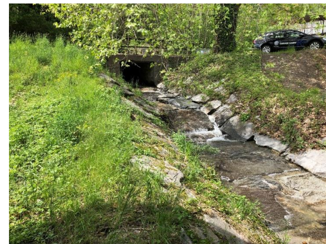
Sbocco del sottopasso della strada cantonale. L'alveo in questo tratto è artificiale con un lastrico di piattoni e beton. Vista verso monte
