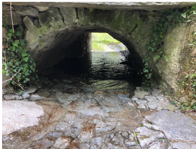
Imbocco dello stretto sottopasso della strada comunale, vista verso valle. Assenza di banchine asciutte per anfibi e piccola fauna
