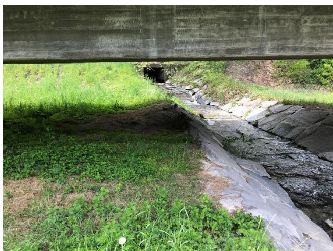
Sbocco del sottopasso e soprastante il viadotto della strada cantonale. La campata del viadotto garantisce disponibilità di spazio sui due lati del sottopasso
