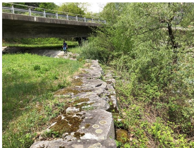
Zona di confluenza del torrente Rialone nel fiume Ticino. In primo piano si vede l'argine principale, vista verso monte
