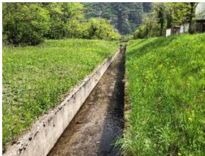
Aspetto attuale del canale Mairano, vista da monte verso il fiume Ticino
