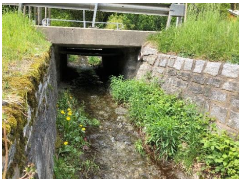
Riale Mairano nord, sottopasso della strada cantonale e alveo artificiale
