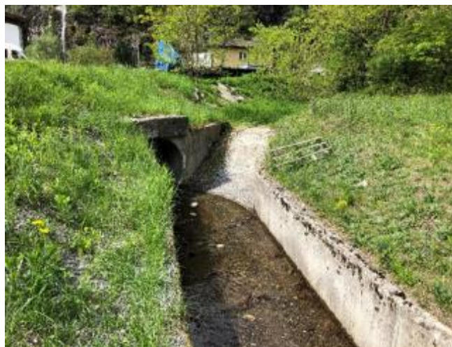
Sbocco del tombinone della strada cantonale e bacino di ritenuta, vista verso monte
