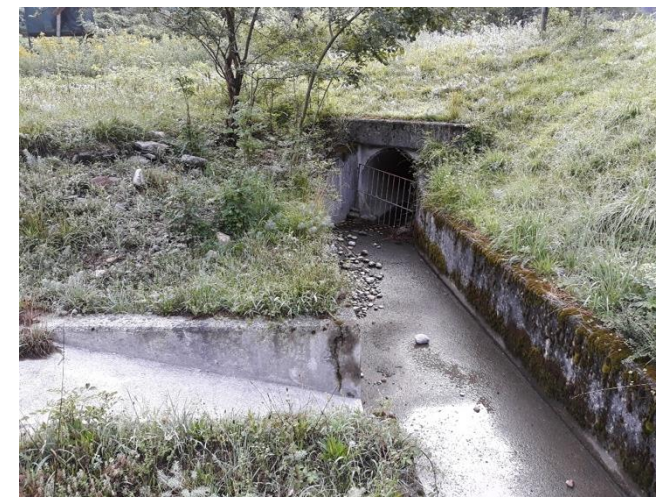
Confluenza del riale di Mairano (troppo pieno biotopo) e imbocco del tombino di attraversamento dell'argine del fiume Ticino, vista verso valle
