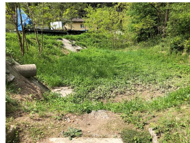
Bacino di ritenuta a valle della strada cantonale, vista verso monte
