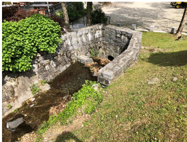
Camera di raccolta all'inizio del tratto intubato sotto ai posteggi (lunghezza tratto intubato ca. 150 m). La limitata capacità dei tubi ha spesso dato luogo in passato a problemi di allagamento dell'area
