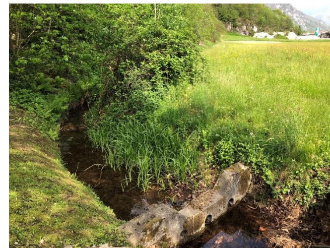
Canale di raccolta acque di versante sul lato nord dei grotti. Presenza di ambienti acquatici con manufatti artificiali e un tombinone che occulta il corso d'acqua a valle di questo punto
