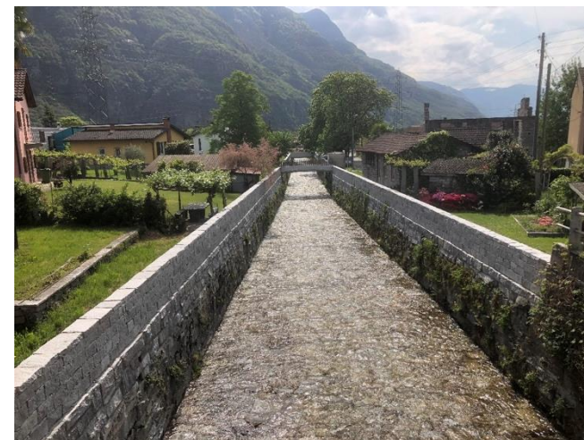
Tratto di riale artificiale nel centro abitato di Iragna. Il tratto è stato oggetto di un recente intervento di innalzamento degli argini a scopo di premunizione idraulica
