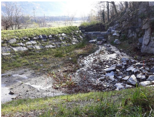
Riale Rodaglio. Vista all'interno della nuova camera di ritenuta, verso valle
