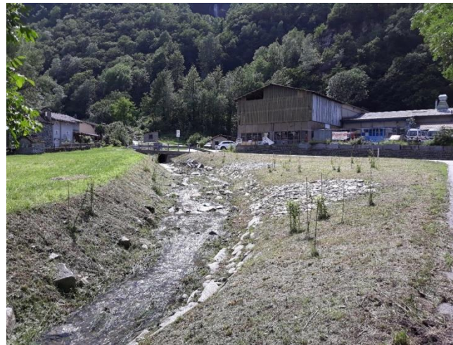
Riale Rodaglio. Tratto a valle della strada cantonale nella primavera 2019, in seguito ai rinverdimenti e circa un anno dopo il termine dei lavori
