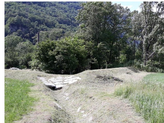
Argine dell'area di laminazione delle piene a valle della località Rodaglio, manufatto di sfioro e canale di scolo riattivato
