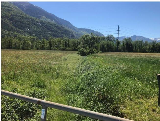
Area agricola di Prosito, si osserva l'alveo di un canale rettificato e banalizzato, con sezione idraulica a U, sponde simmetriche e non funzionali, con copertura vegetale esclusivamente erbacea
