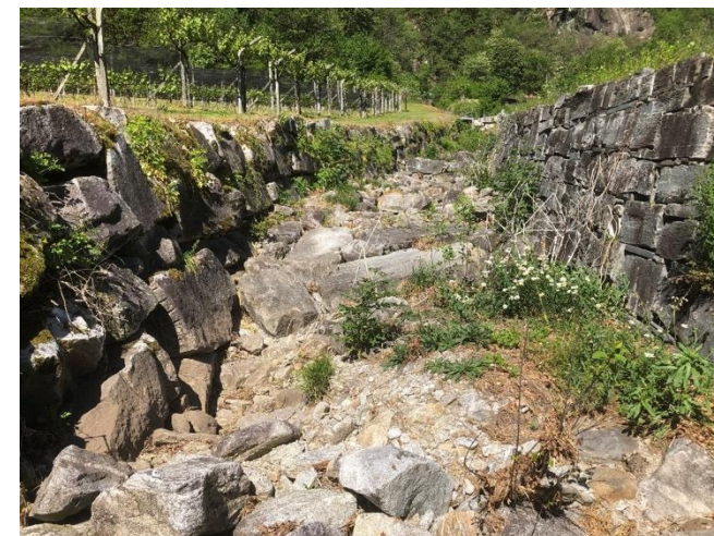
Riale di Prosito, tratto sul conoide verso il nucleo di Prosito. Stato ecomorfologico artificiale. Deficit dovuto principalmente agli argini in blocchi e alla mancanza di vegetazione ripariale e spondale, vista verso monte
