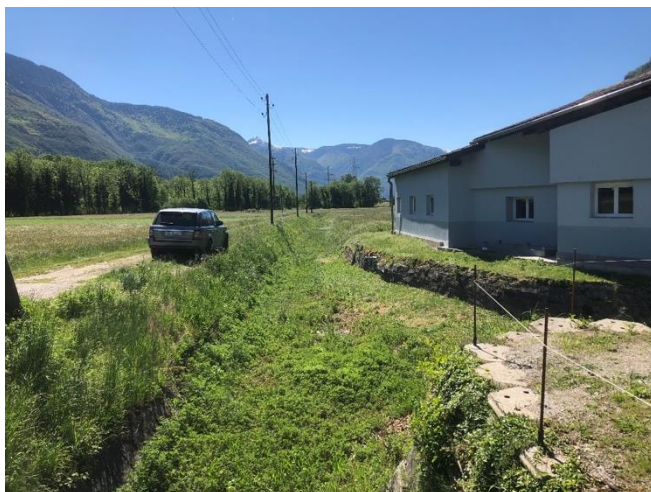
Tratto canalizzato di pianura presso la confluenza dei due rami del riale di Prosito, a valle della strada cantonale. In lontananza si osservano l'area agricola attraversata dal corso d'acqua e la golena del Ticino
