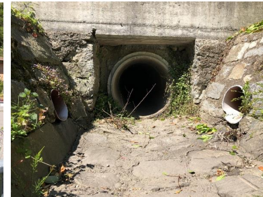
Sottopasso stradale da riqualficare
