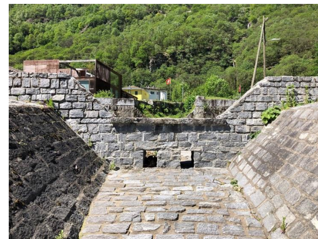
Riale da Dinn, camera di ritenuta a monte della strada cantonale e alveo artificiale del corso d'acqua (fondo in lastrico e sponde artificiali) vista verso monte
