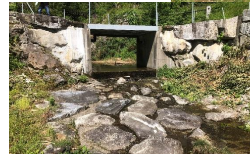
Sopra e a lato: rimozione o correzione degli ostacoli trasversali in alveo. Il salto di fondo presso il ponte della strada vicino al nucleo di Prosito e briglia a monte del ponte
