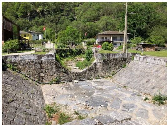
Camera di ritenuta artificiale con ostacoli da risanare: briglia trasversale e salto di fondo
