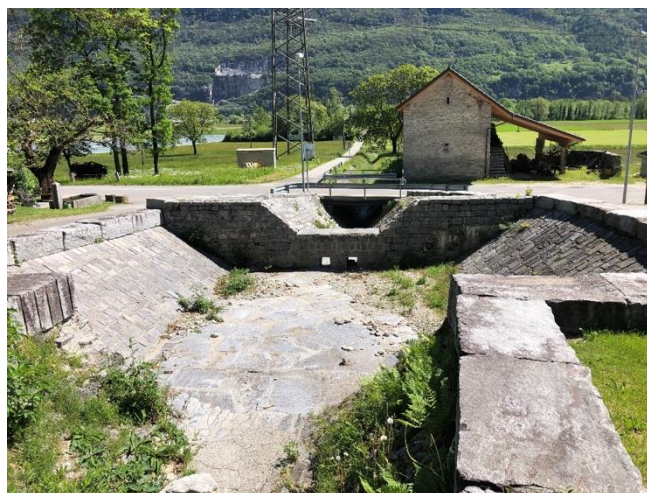
Riale da Dinn, alveo artificiale completamente deficitario presso la camera di ritenuta a monte della strada cantonale. Immagine ripresa verso valle, è ben visibile il ponte stradale
