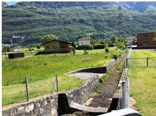
Ostacolo trasversale in alveo da risanare per riconnettere i tratti a monte e a valle, con possibilità di rinaturare il fondo e le sponde attualmente artificiali (tratto compreso tra la strada comunale e quella cantonale)
