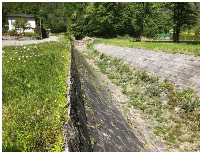
Riale di Prosito, alveo artificiale consolidato in duro a monte della strada cantonale, vista verso monte
