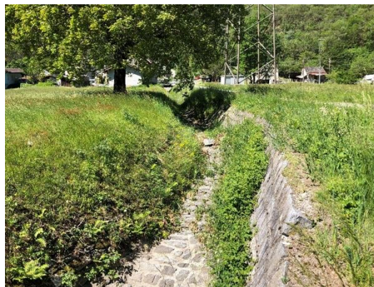
Tratto a valle della strada cantonale: consolidamento in duro del fondo e delle sponde da riqualficare, e presenza di un ostacolo trasversale in alveo da rimuovere
