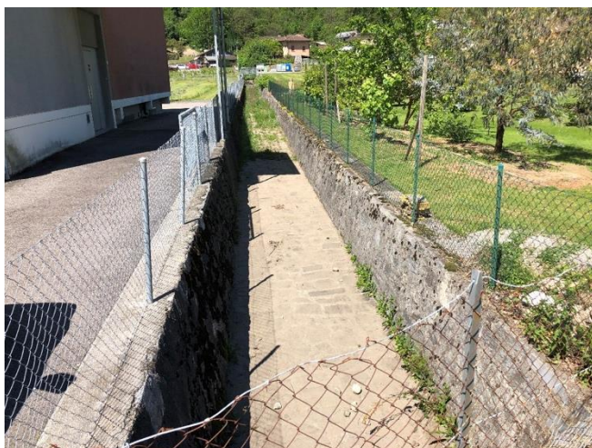
Riale di Prosito nord, tratto di riale completamente artificiale nella zona residenziale di Prosito. Vista verso monte dal ponte della strada cantonale (tratto compreso tra la strada cantonale e la strada comunale)
