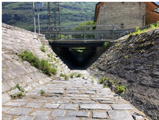
Alveo e sponde artificiali lastricate e sottopasso della strada cantonale
