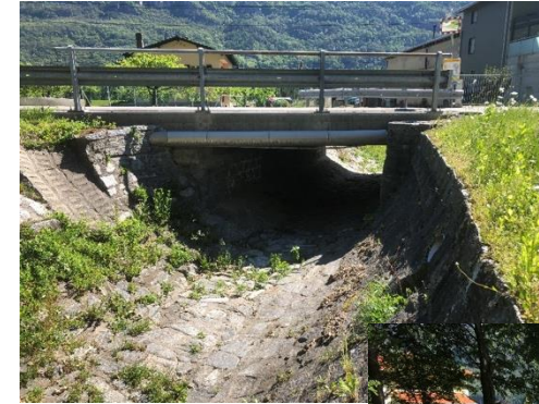
A lato: riqualifica sottopasso strada cantonale Sotto: rimozione o correzione ostacoli trasversali in alveo, briglia e camera di ritenuta
