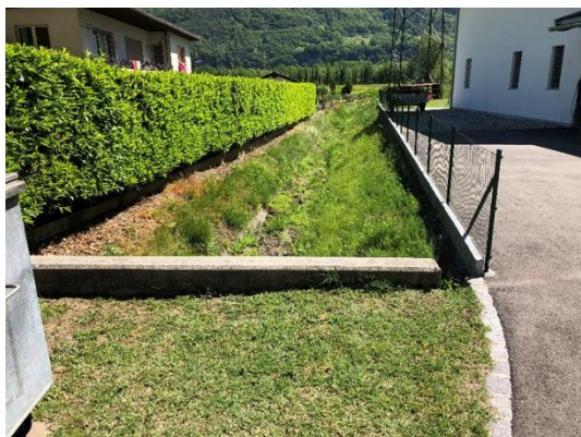
Alveo e sponde fortemente modificate a valle del sottopasso della strada cantonale, stretti tra due zone edificate. Questo breve tratto potrebbe essere rinaturato per favorire il collegamento ecologico tra le zone agricole a valle e i versanti montani
