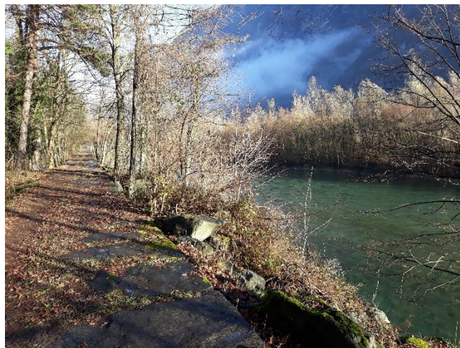
La sponda destra del Ticino nella tratta tra Iragna e Lodrino è occupata per tutta la sua lunghezza (4'100 ml) da un argine artificiale rettilineo
