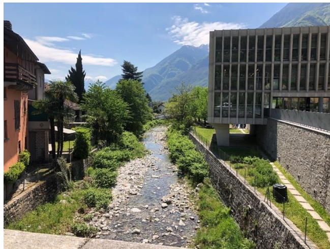
Deficit di vegetazione ripariale e presenza consistente di neofite sulle sponde; vista dal ponte della strada comunale verso valle
