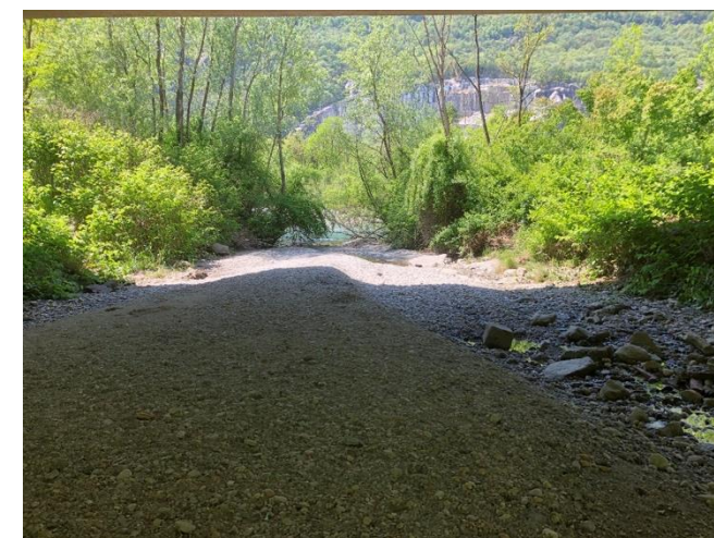
Foce della Nala nel Ticino sotto il viadotto strada nazionale A2, vista verso valle
