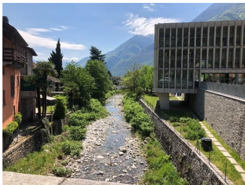
Inizio via d'acqua Nala, strutture comunali e riale, vista verso valle dal ponte vecchio
