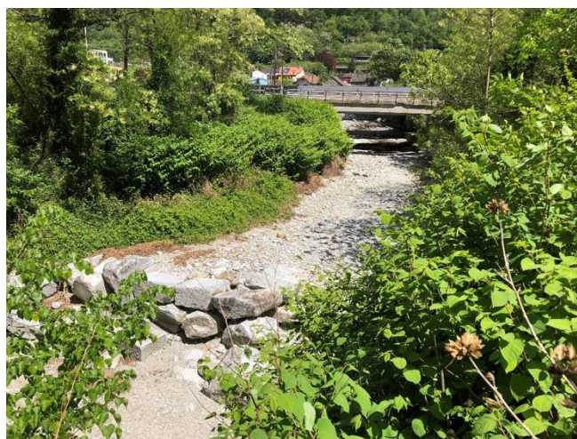
Salto di fondo in blocchi a valle della strada cantonale, golena con forte presenza di neofite (poligono del Giappone), deflussi residui insufficienti; vista verso monte
