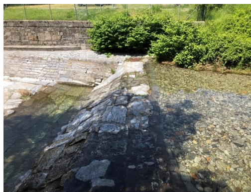
Dettaglio salto di fondo a monte della ferrovia
