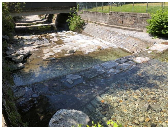
Salto di fondo e consolidamento dell'alveo presso linea FFS e strada cantonale; vista verso valle
