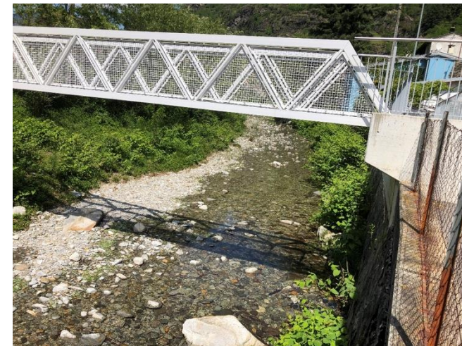
Riale Nala presso la nuova passerella comunale, forte presenza di neofite invasive (Poligono del Giappone) in alveo, vista verso monte
