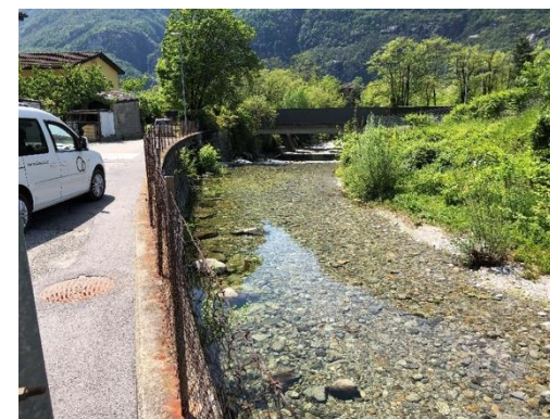
Viadotto FFS visto da monte, lungo il vicolo Nala
