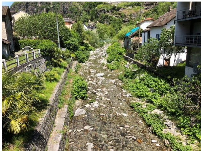
Deficit di vegetazione ripariale e presenza consistente di neofite sulle sponde; vista dal ponte della strada comunale verso monte
