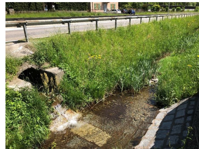
Sbocco dell'attraversamento della strada cantonale, da qui verso valle il riale scorre sotto forma di un canale artificiale fino alla confluenza con il Ticino
