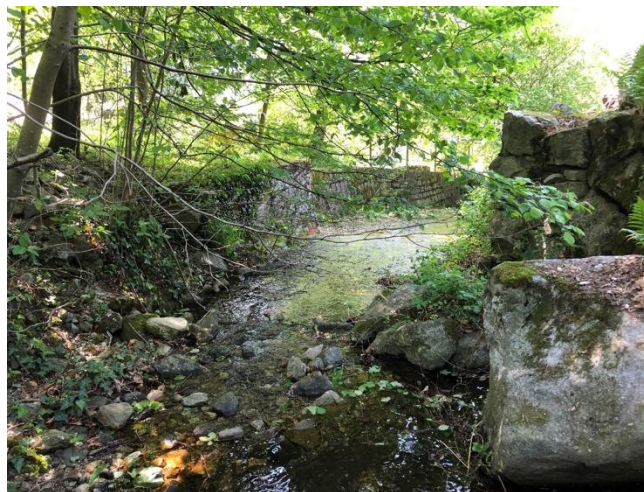
L'inizio del tratto di riale modificato artificialmente si trova in corrispondenza di questa camera di ritenuta, formata da mura in blocchetti di pietra fuggati e da un fondo in lastrico di simili blocchetti
