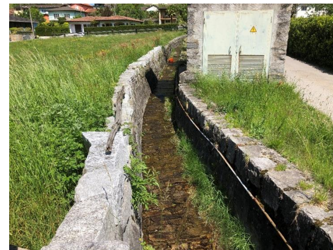
Riale artificiale visto verso monte dal ponte di via Via Torón d'Örz, presenza di infrastrutture tra la strada e il riale
