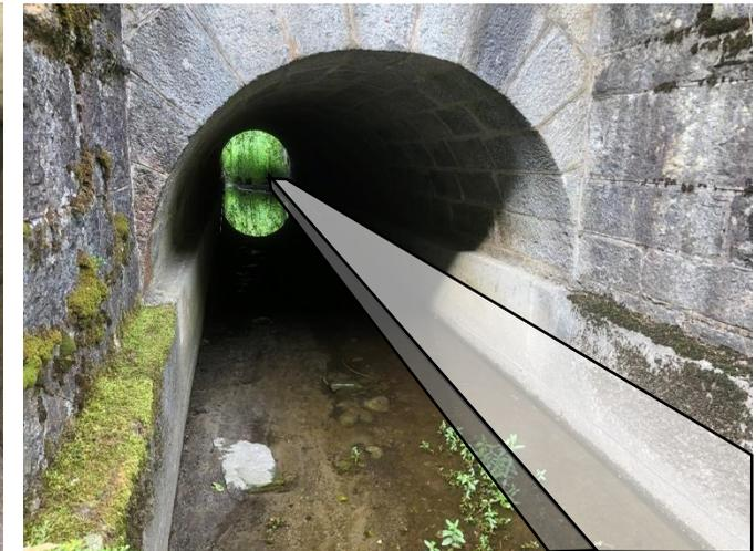
Sottopasso FFS da adeguare per la piccola fauna (assenza di banchine di larghezza sufficiente)
