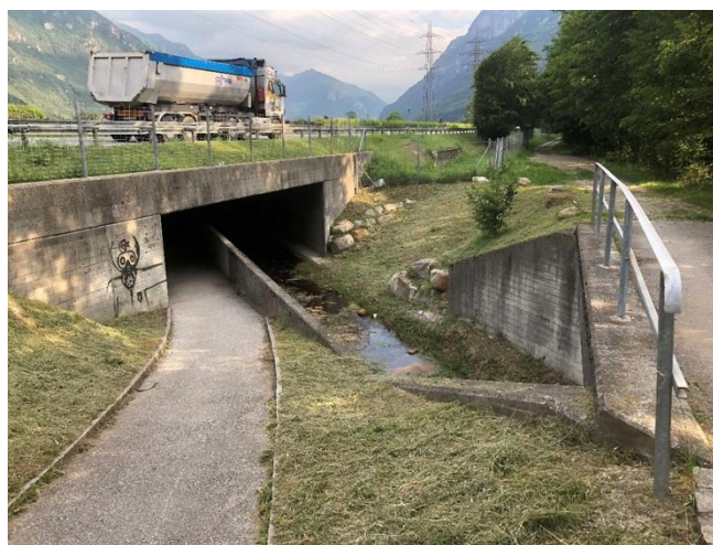
Uscita del sottopasso autostradale e ponte della strada d'argine del Ticino
