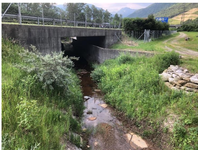
Ingresso del sottopasso della strada nazionale 2, vista verso valle. L'alveo del riale è artificiale e presenta un muro in beton in sponda destra che lo separa dal sottopasso di una strada carrabile di servizio
