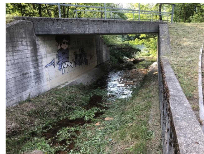
Dettaglio del ponte dell'argine insommergibile e della confluenza con il Ticino, dove è presente un salto di fondo
