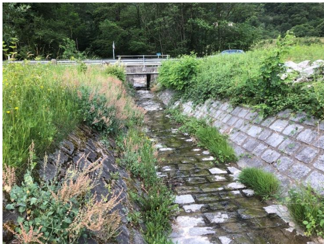
Tratto artificiale del riale Cima d'Aspra/Spineda, compreso tra l'autostrada e la strada cantonale, il cui sottopasso è visibile in secondo piano
