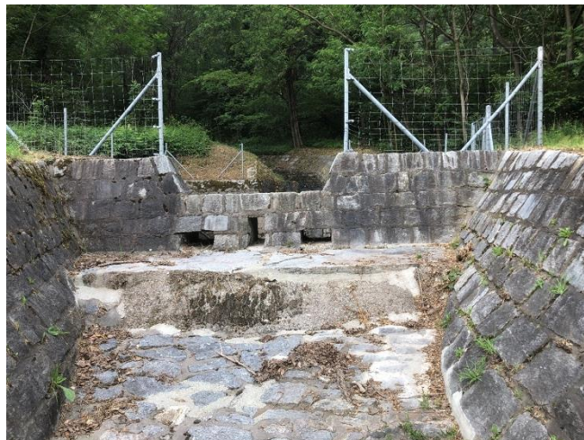
Camera di ritenuta lungo il riale Cima d'Aspra/Spineda, situata a monte della strada cantonale
