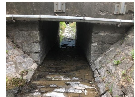
Sottopasso strada cantonale a valle della camera della foto precedente, da risanare secondo la norma VSS 640696
