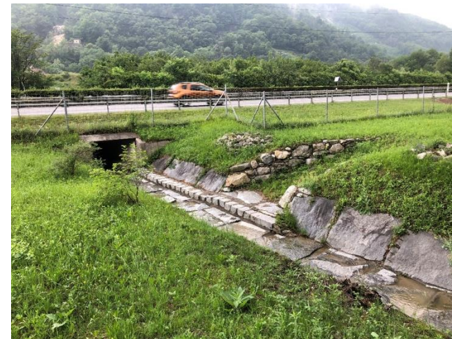
Riale Cima d'Aspra/Spineda, sottopasso dell'autostrada N2, oggetto di un intervento per migliorare la funzionalità del passaggio faunistico: rampa laterale di accesso e banchina in sponda destra
