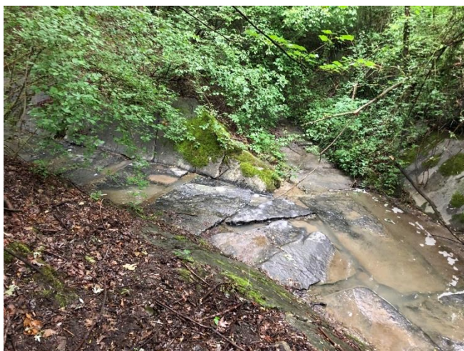
Confluenza dei riali Cima d'Aspra/Spineda, caratterizzati da un alveo artificiale (lastrico fucato in beton) all'interno della gola del fiume Ticino
