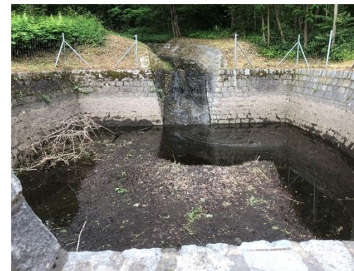
Camera di ritenuta lungo il riale Cima d'Aspra a monte della strada cantonale, attualmente costituisce un ostacolo difficilmente valicabile per la fauna terrestre e anfibia, e deve essere risanato
