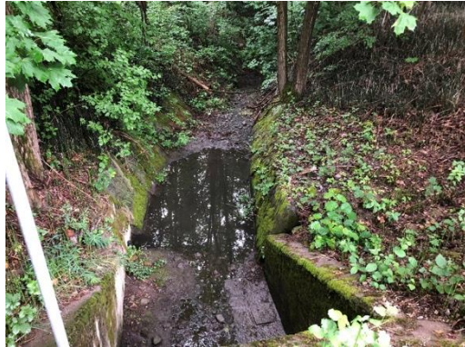
A sinistra: sbocco del sottopasso USTRA e inizio del tratto lastricato artificiale del riale Cima d'Aspra in golenia
