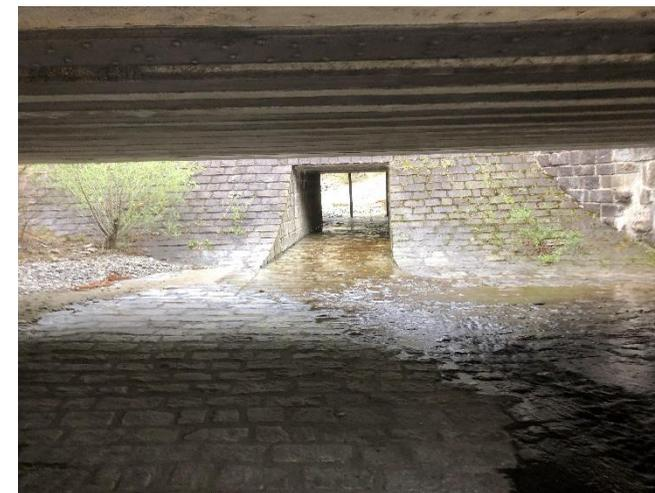
Torrente Boggera: sottopasso e briglia di ritenuta. In progetto interventi per migliorare la dinamica dei sedimenti e la funzionalità del passaggio faunistico
