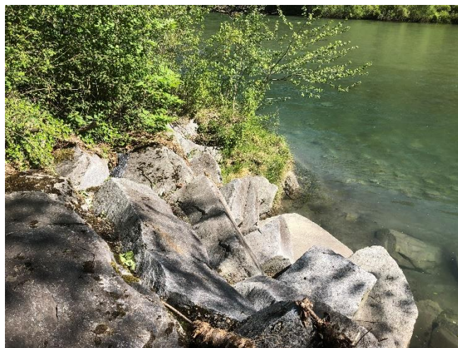
Dettaglio dell'argine attuale del fiume Ticino in sponda destra presso la foce del riale di Prosito
