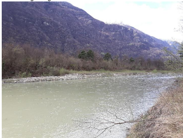
Fiume Ticino rettificato in corrispondenza della stazione di servizio lungo l'autostrada N2, vista verso monte dalla sponda sinistra, immediatamente a valle del tratto in esame. La larghezza del fondo dell'alveo è pari mediamente a 70-80 m, non dando la possibilità al corso d'acqua di sviluppare completamente gli ambienti acquatici come in condizioni naturali (100 ml ca.). Per il raggiungimento del 100% degli obiettivi di funzionalità secondo il metodo di valutazione UFAM (Paccaud & Roulier, 2013) sarebbe necessario al fiume uno spazio mobilità di ca. 250 m
