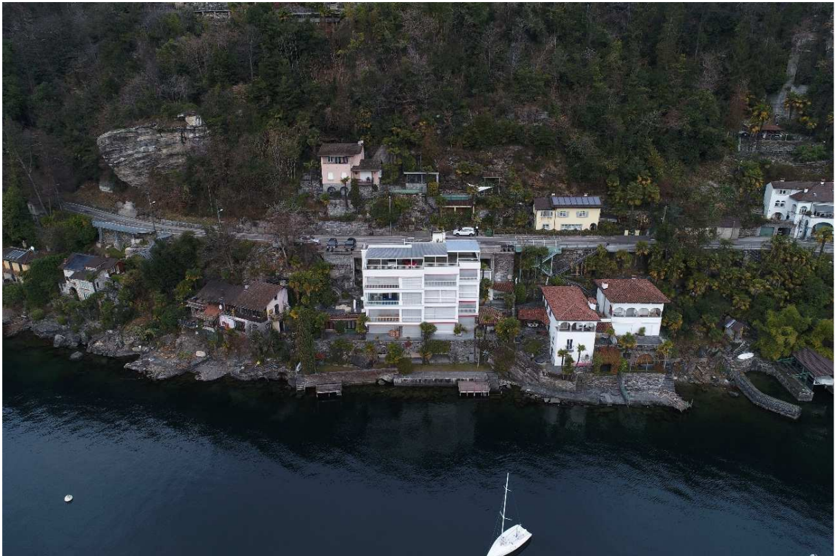
Figura 19: Esempio di riva densamente edificata in comune di Ascona. Lo spazio ridotto a riva e l'elevata pendenza hanno comportato una penalizzazione da BSIG elevato a medio.
