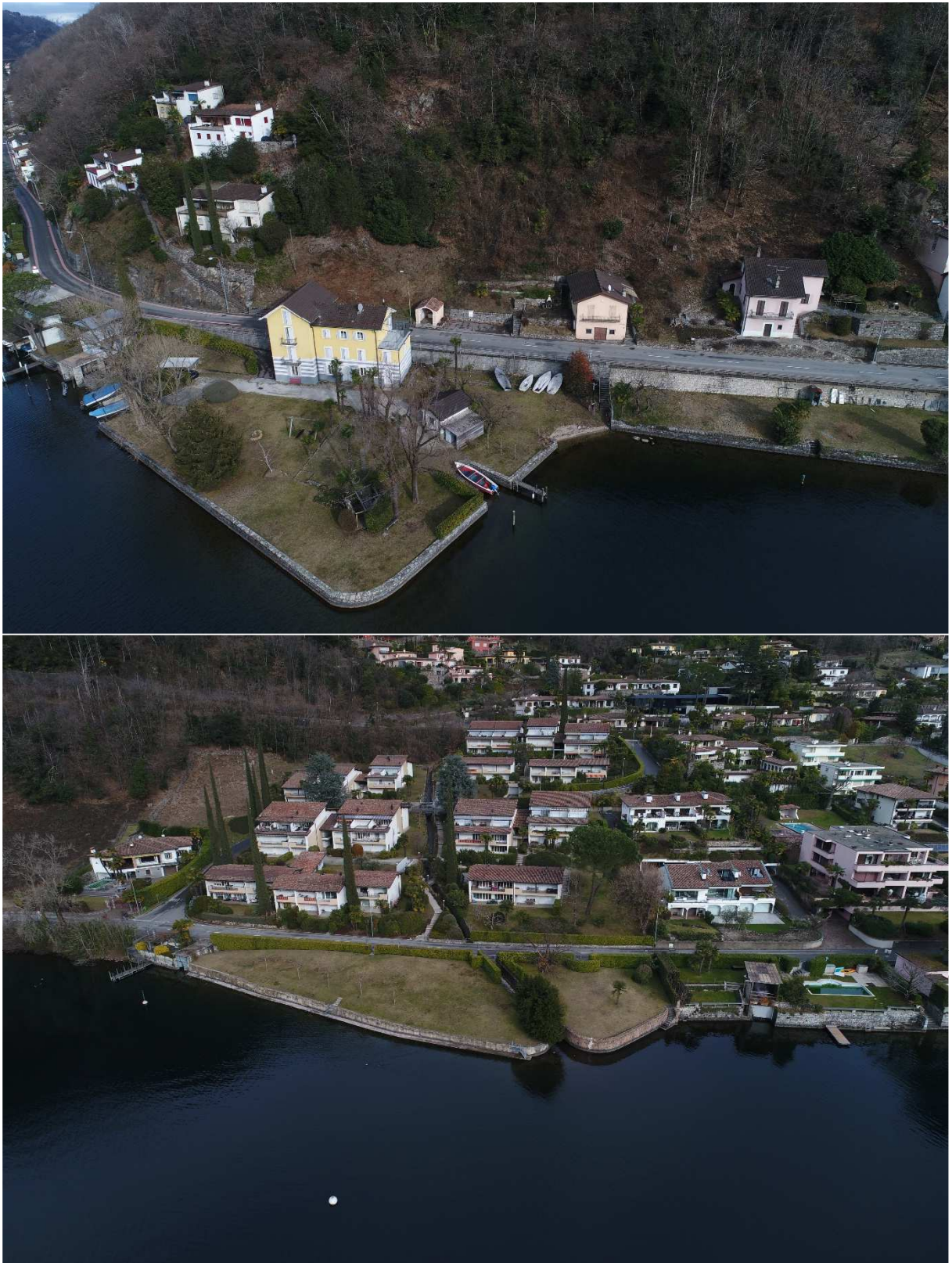
Figura 13: Tratti di riva a beneficio di rivitalizzazione elevato presso Morcote: casa doganale (in alto) e foce del riale Valle di Fiume (in basso). Fonte: UCA, Oblivion Aerial SA.
