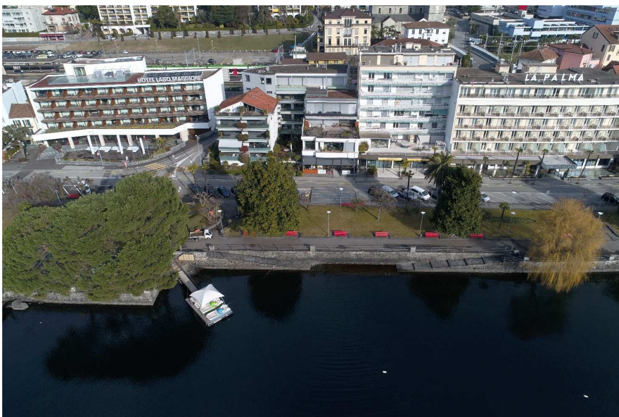
Figura 16: Lungolago tipo "Lombardo" a Muralto, con presenza di muri storici a riva. Le condizioni locali generano valori di PV alti, con conseguente classificazione in BSIG elevato. Con il processo di plausibilizzazione queste rive sono state declassate a valori medi.
