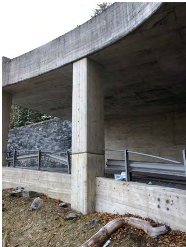
28. Pilastro P2, veduta generale
