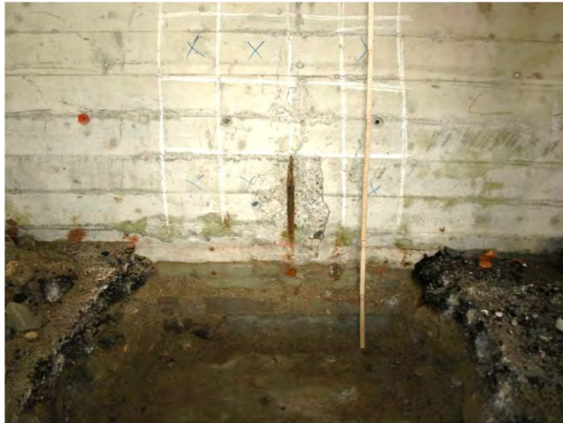
89. Finestra n. 2 e posizione carotaggi
