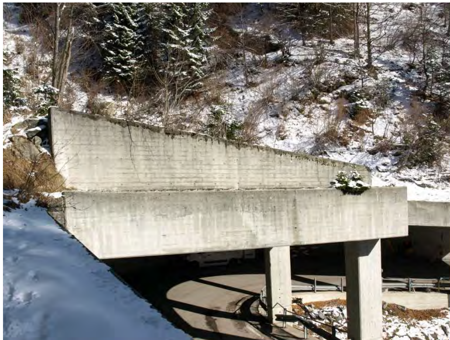
71. Muro di protezione sopra soletta, lato Campo VM
