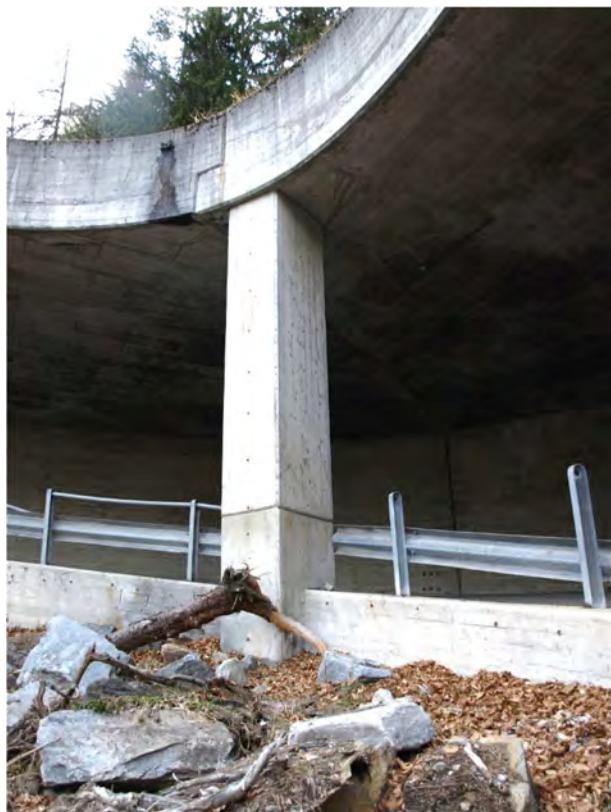
31. Pilastro P3, veduta generale
