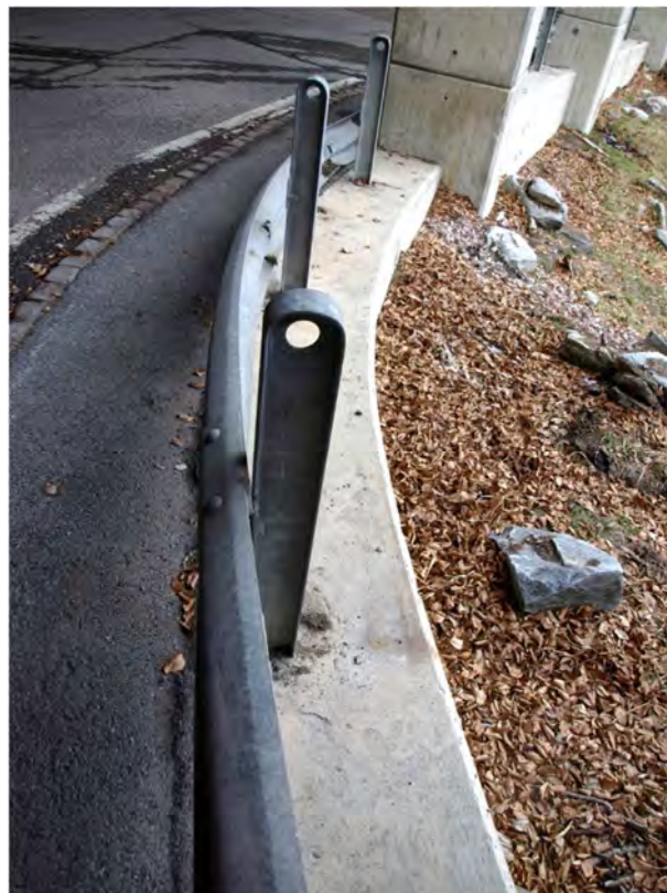
51. Trave T3, vista da sopra
