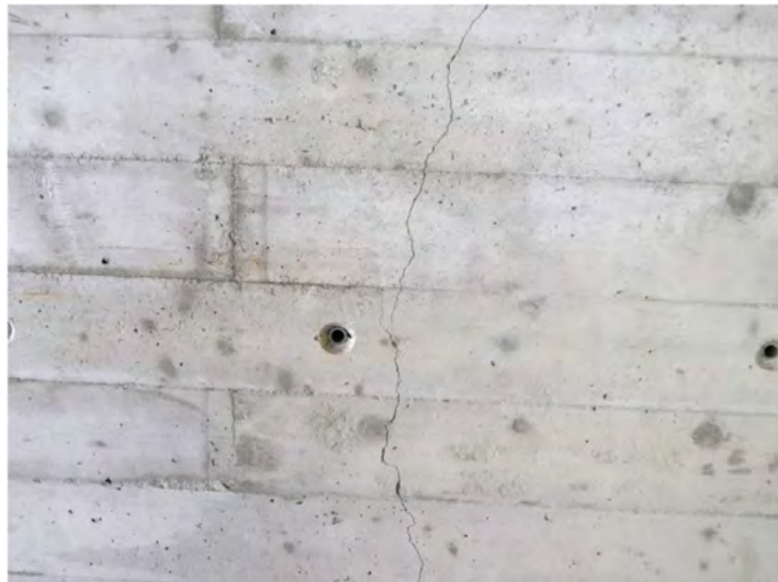
10. Dettaglio fessura
