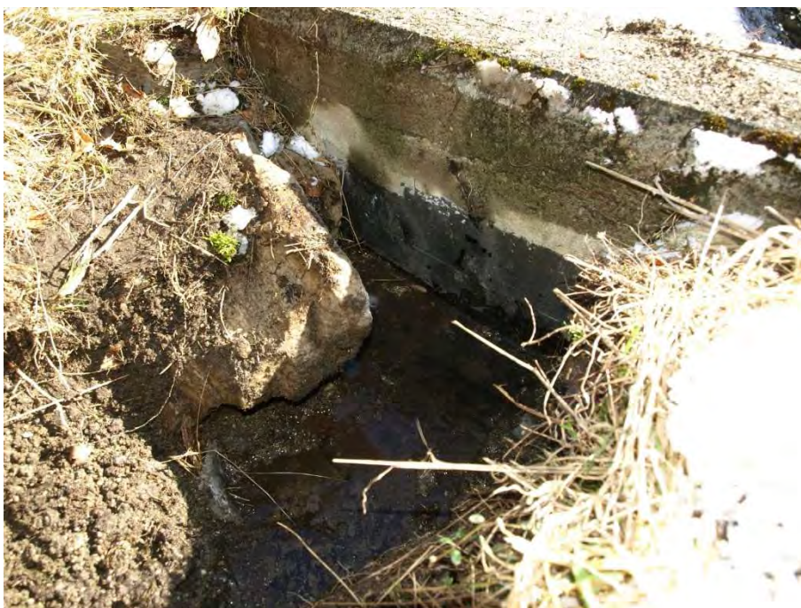
79. Sondaggio n.2, stratigrafia: solo carta catramata e terra (da 25 a 40 cm)
