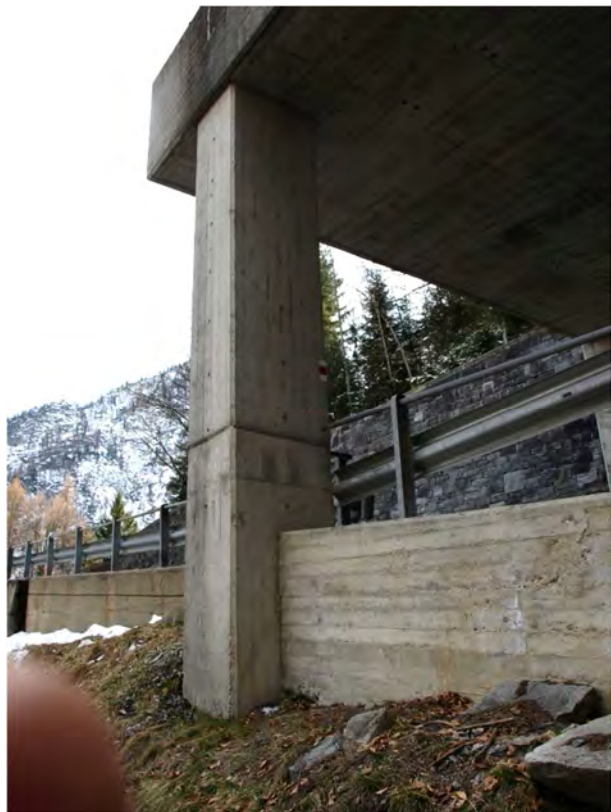
25. Pilastro P1, veduta generale.
