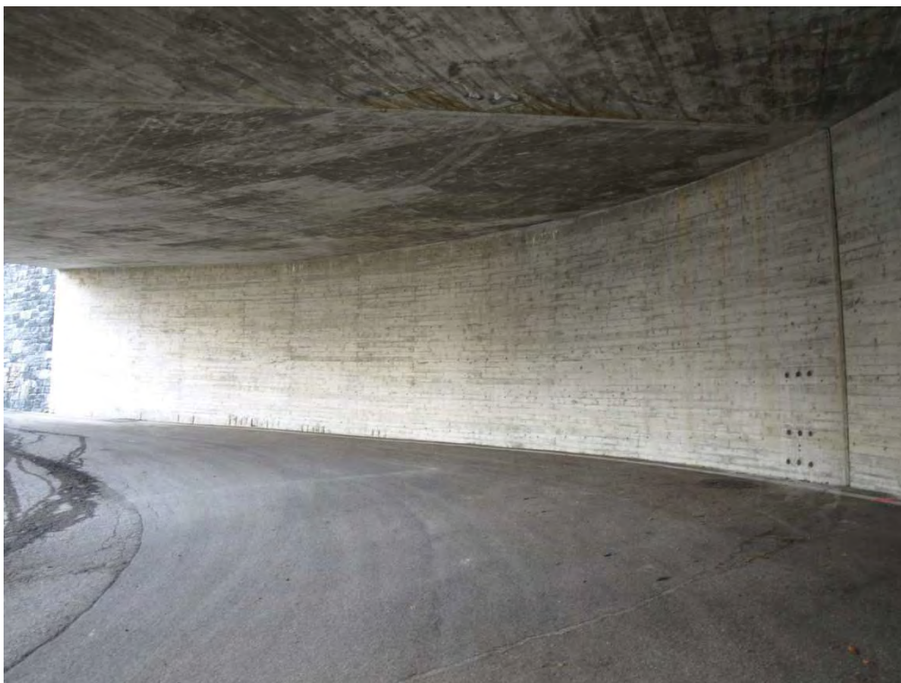
5. Muro zona A, veduta generale
