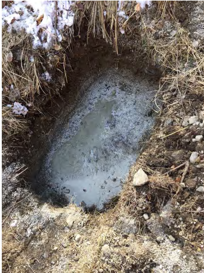
80. Sondaggio n.3, stratigrafia: solo calcestruzzo, senza carta catramata
