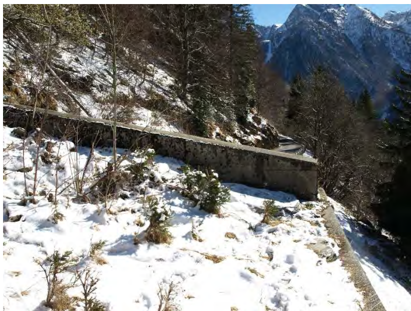
82. Accumulo materiale vicino alla trave di protezione, lato Cerentino
