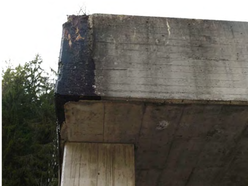
57. Soletta, dettaglio scolo dell'acqua
