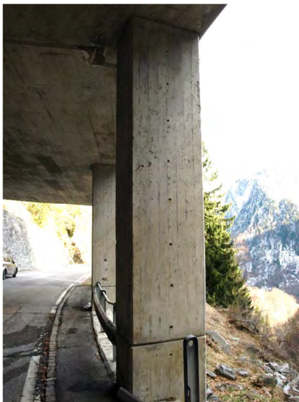
35. Pilastro P4, veduta da Campo VM
