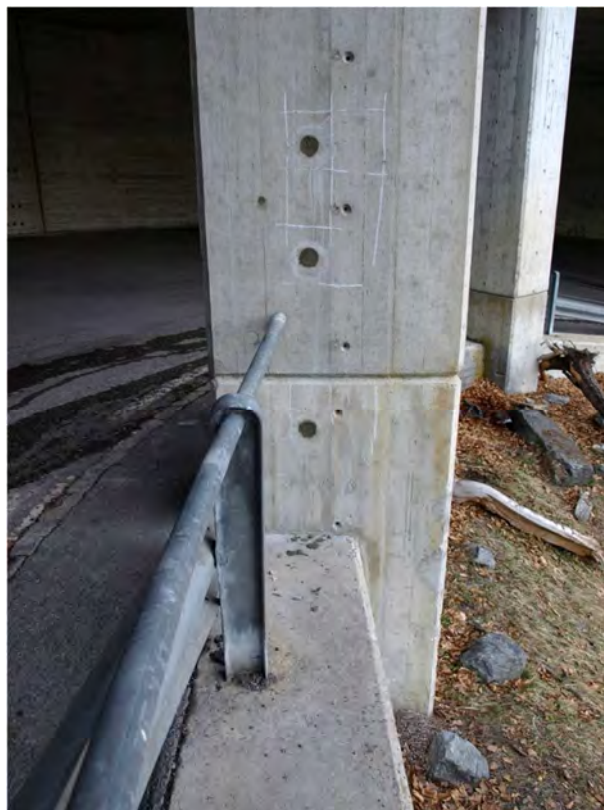
29. Pilastro P2, carotaggi
