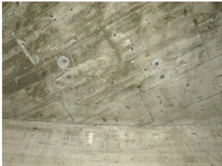
69. Soletta, carotaggi zona B, foto verso monte
