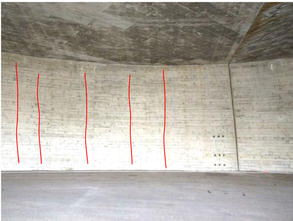
8. Muro zona A, parte terminale
