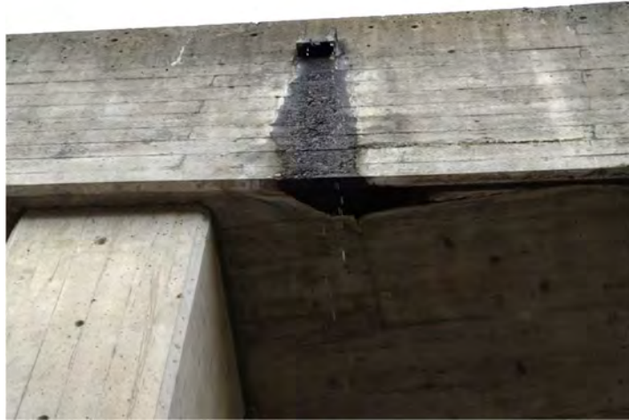
63. Soletta, dettaglio scolo dell'acqua
