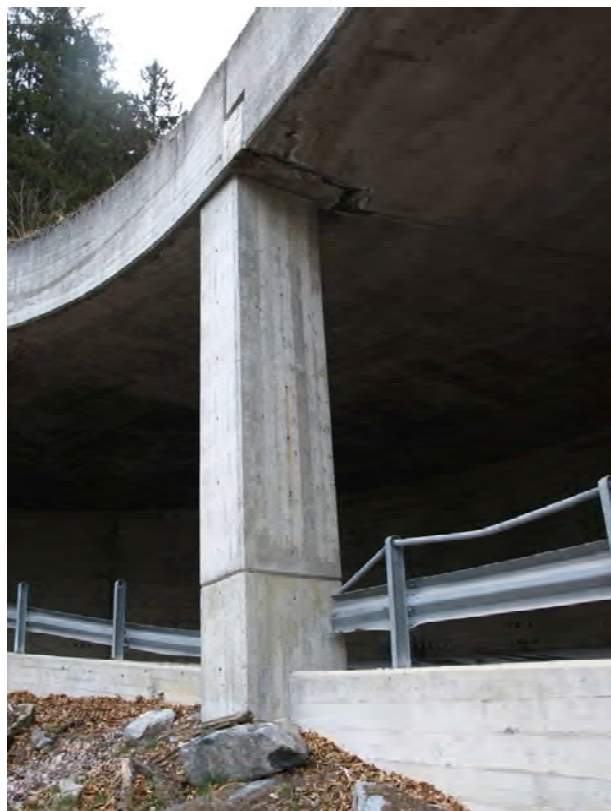
34. Pilastro P4, veduta generale
