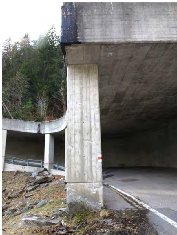
40. Pilastro P6, veduta generale da Cerentino
