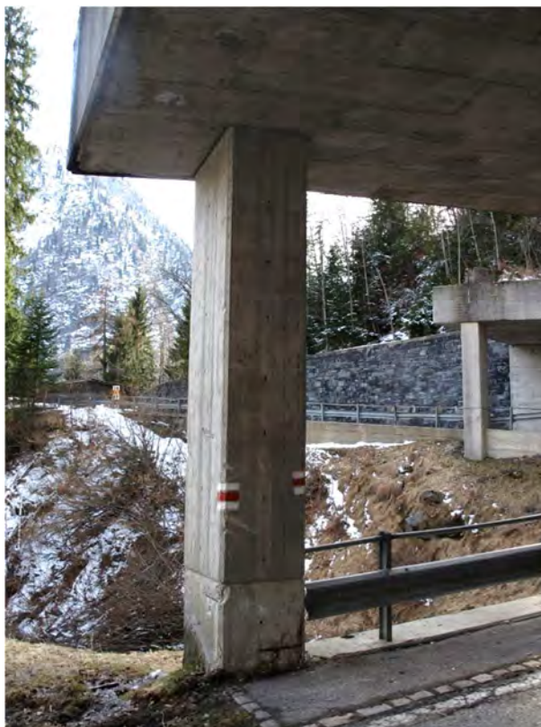
41. Pilastro P6, veduta interna
