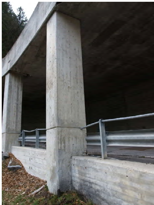
37. Pilastro P5, veduta generale
