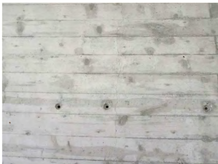
11. Dettaglio fessura
