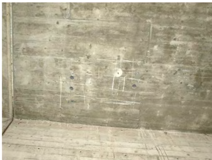
70. Soletta, carotaggi zona C, foto verso monte
