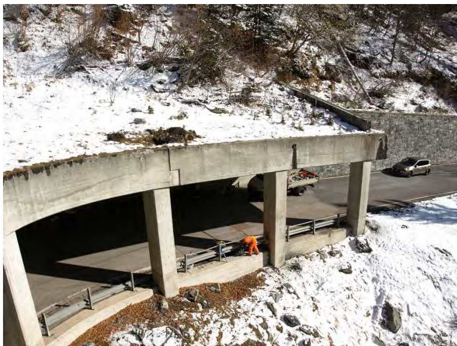
72. Copertura e muro di protezione lato Cerentino
