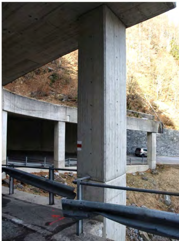
26. Pilastro P1 dall'interno. Nessun difetto
