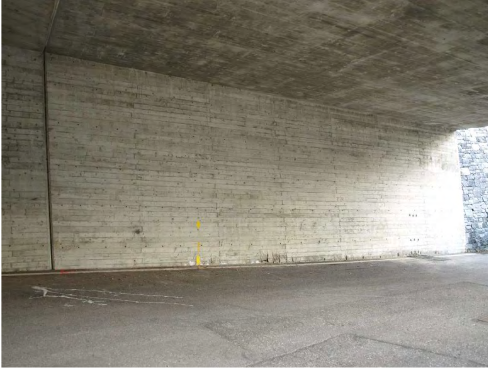
20. Muro zona C, veduta generale
