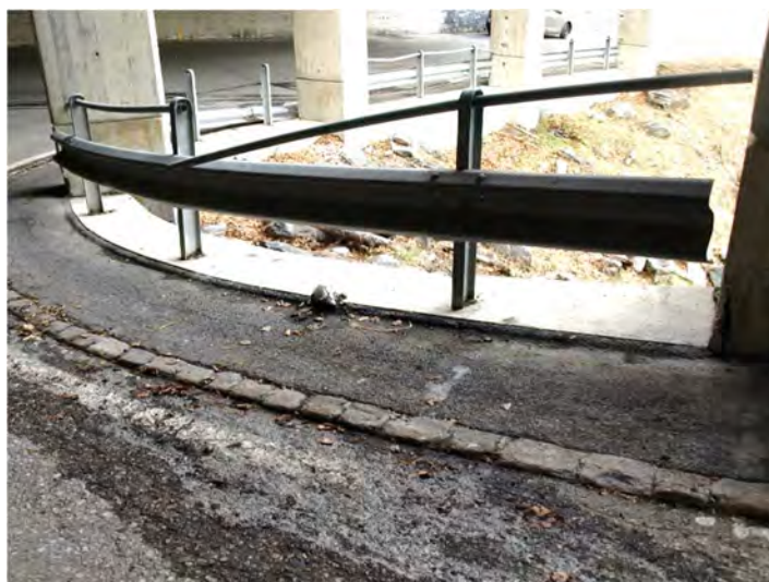
49. Trave T2, vista dall'interno
