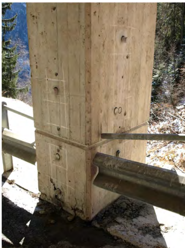
38. Pilastro P5, carotaggi
