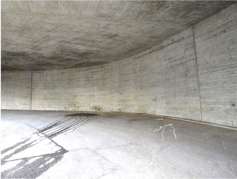
13. Muro zona B, veduta generale
