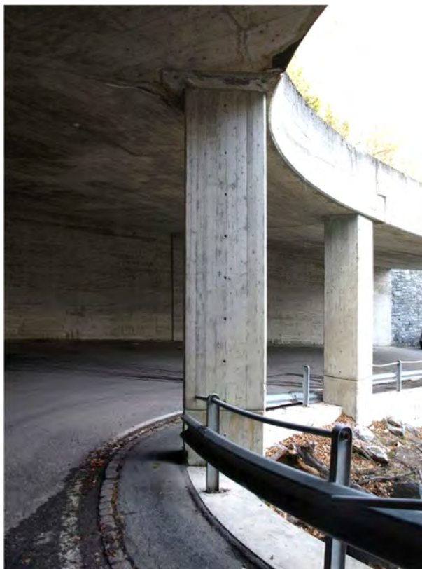
32. Pilastro P3, veduta da Campo VM
