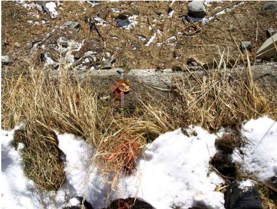
73. Dettaglio giunto nel cordolo lato Cerentino
