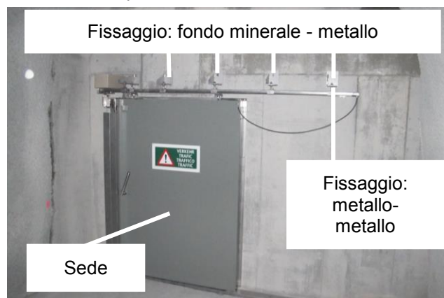
Rapp. 14: Porta di via di fuga
