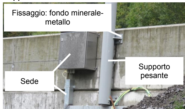
Rapp. 4: Base del montante videocamera, scatola di comando
