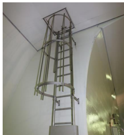
Scala per ascendere al canale di aria viziata
