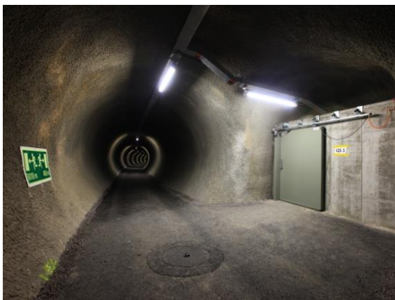
Cunicolo di sicurezza
