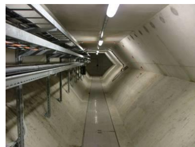
Zona 30 : Galleria tecnica
