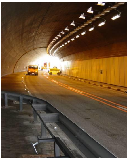
Zona 20 : Vano traffico
