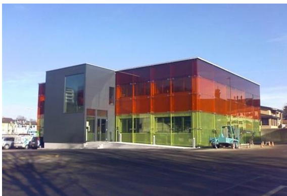
Centrale di comando
