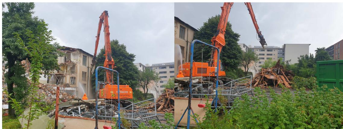
*Figura 34 Demolizione ex Vanoni: A sinistra raccolta dei metalli, a destra raccolta dei materiali lignei*
