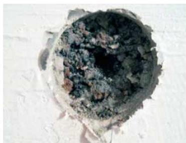
Figura 13, Esempio di isolamento di sughero catramato dietro un intonaco. Fonte: Bayerisches Landesamt für Umwelt (LfU), Rückbau schadstoffbelasteter. Bausubstanz. Arbeitshilfe Rückbau: Erkundung, Planung, Ausführung, 2019.
