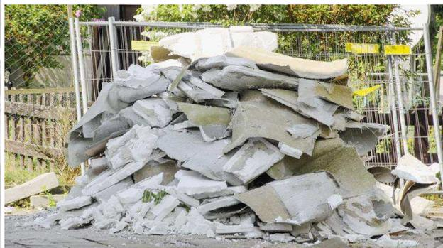
*Figura 27 Isolamento esterno di facciata rimosso con metodo parzialmente selettivo.*
