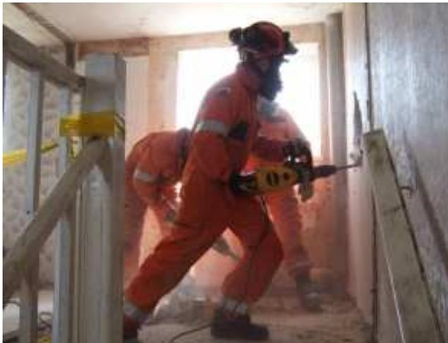
*Figura 39 Strip out: rimozione di intonaco contenente sostanze pericolose.*
