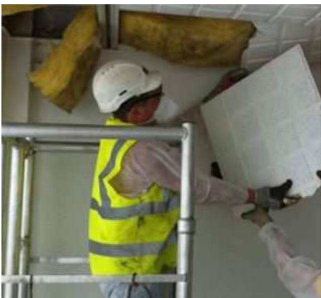
*Figura 40 Strip out: rimozione lastre controsoffitto contenente amianto.*
