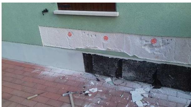
*Figura 31 Rimozione manuale dello strato di intonaco. Strato isolante pannelli in EPS. Uso di utensili da taglio, scalpellatura e smerigliatrice (rimozione manuale).*
