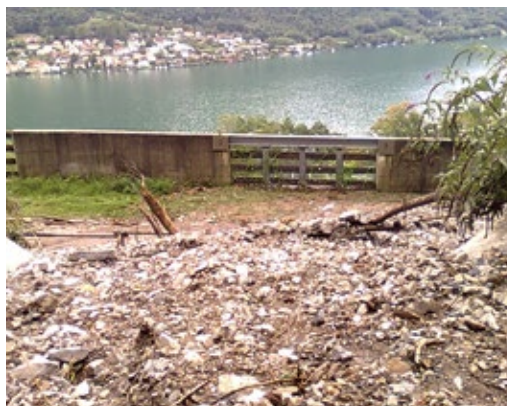
Figura 16 - Camera di raccolta colma di materiale inerte e legname.
