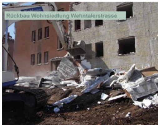
Figura 15 – Esempi di rimozione di un cappotto termico in EPS/XPS (sopra) e demolizione di un pavimento con materassino fonoassorbente (fonte: 9 ).
