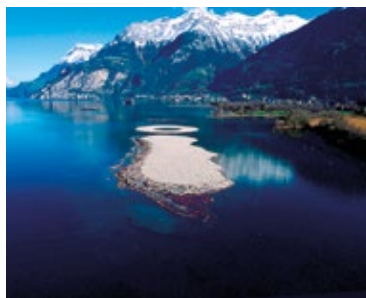
Figura 14 - Esempio di riporto a lago per la formazione di nuove isole nel lago di URI (fonte: www.reussdelta.ch ).
