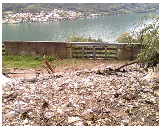
Figura 16 – Camera di raccolta colma di materiale inerte e legname.
