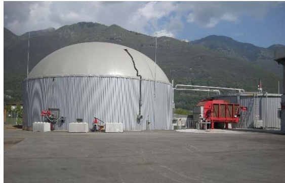
Figura 24 - Impianto di fermentazione (S. Antonino)
