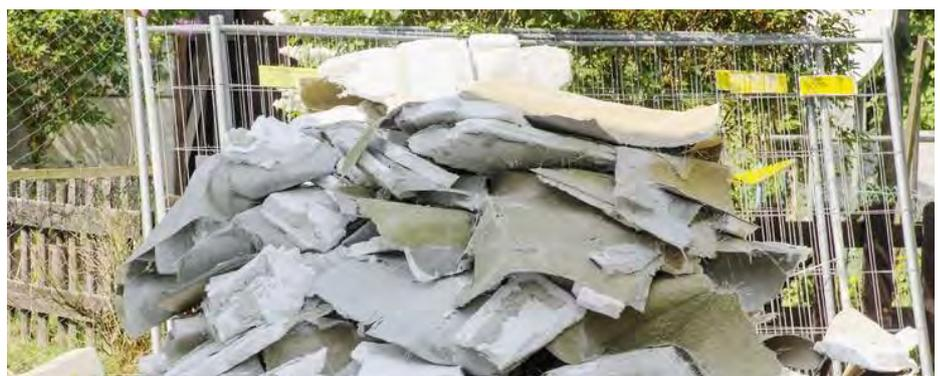
Raccolta separata del materiale isolante su suolo pavimentato.
