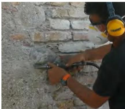
Rimozione, scarpellatura con martello pneumatico
