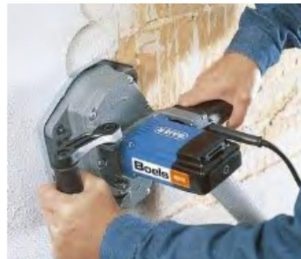
Fresatura con fresatrice a disco
