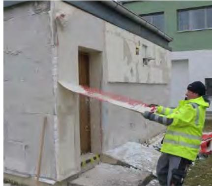
Rimozione manuale dell'intonaco
