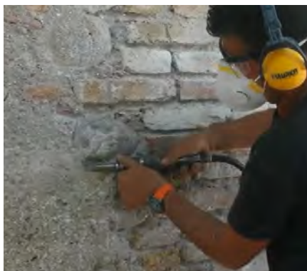
Rimozione, scalpellatura con martello pneumatico
