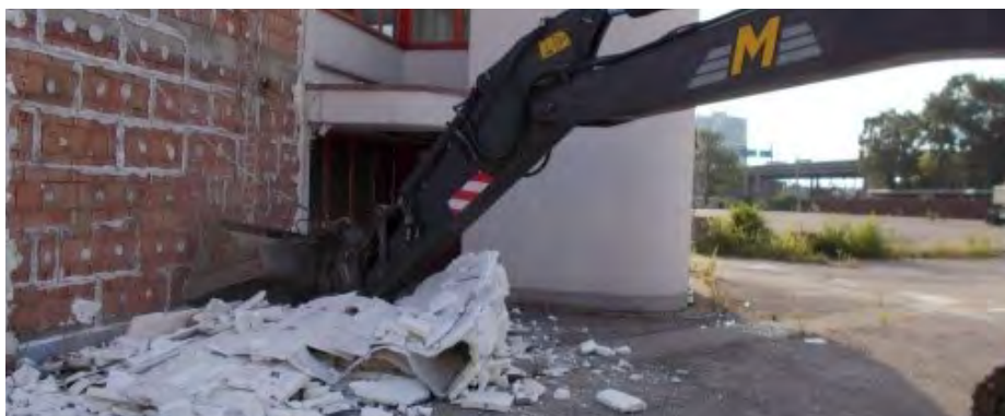
Rimozione meccanica con benna prensile
