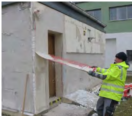
Rimozione manuale dell'intonaco
