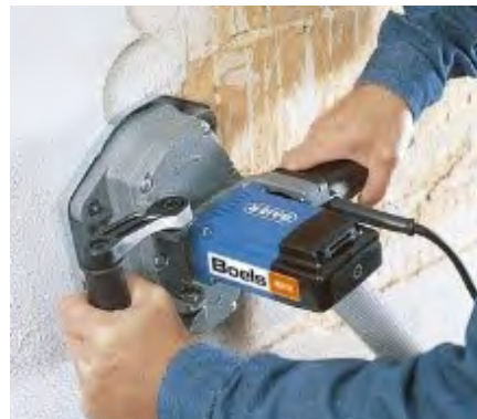
Fresatura con fresatrice a disco
