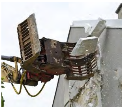
Rimozione meccanica con benna prensile
