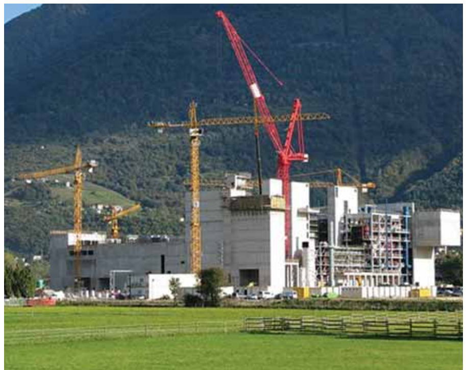
Cantiere ICTR a Giubiasco (situazione ottobre 2008).
