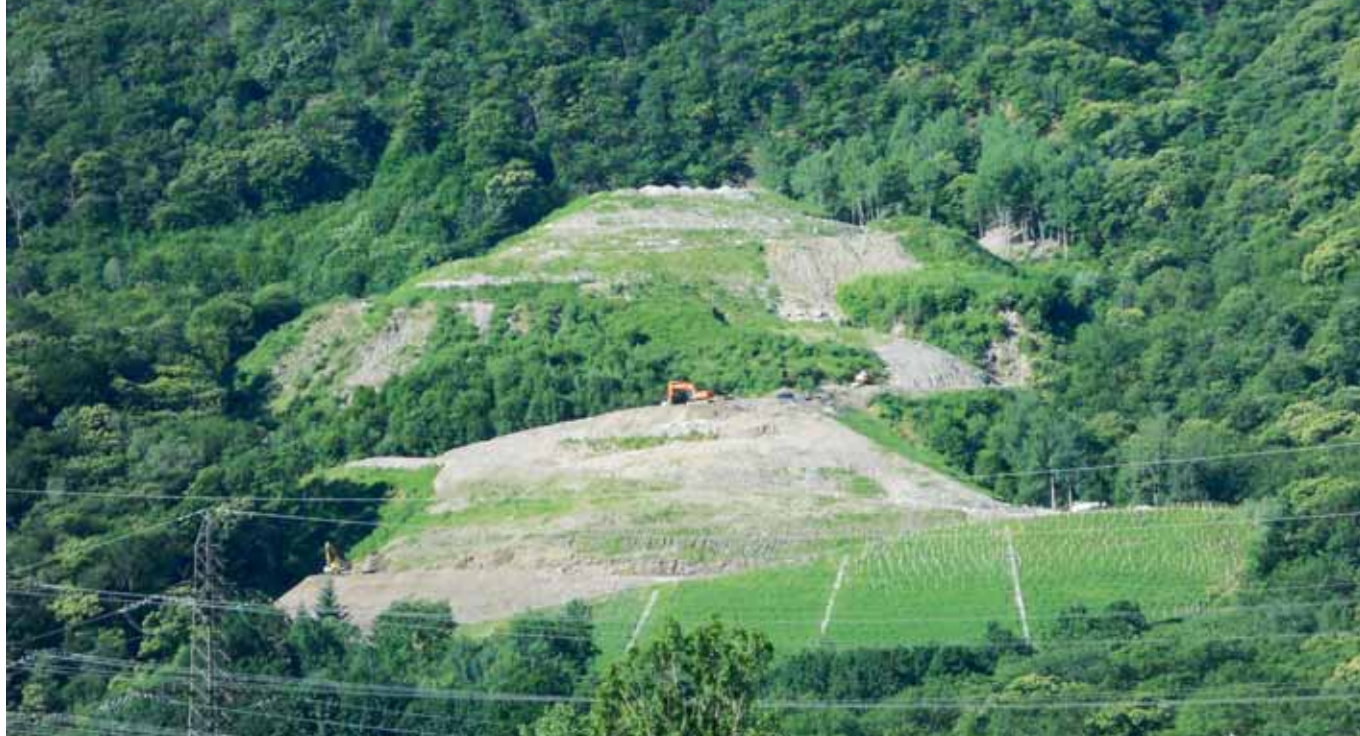
Discarica di Gnosca: messa in deposito di materiale (in alto) e parallela sistemazione delle scarpate definitive mediante rinverdimento e rimboschimento (in basso).
