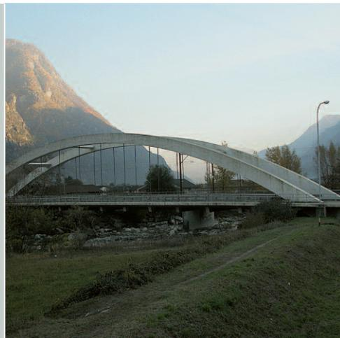
Il manufatto in cemento armato, costruito per sostituire un ponte stradale distrutto dall'alluvione dell'agosto del 1951, è caratterizzato da un sottile arco allungato che tocca al centro la soletta carreggiabile, sostenuta da una lunga serie di cavalletti. L'elegante e slanciato manufatto, indubbiamente debitore della lezione dell'ing. Robert Maillart, caratterizza il paesaggio fluviale della media valle del Vedeggio.
