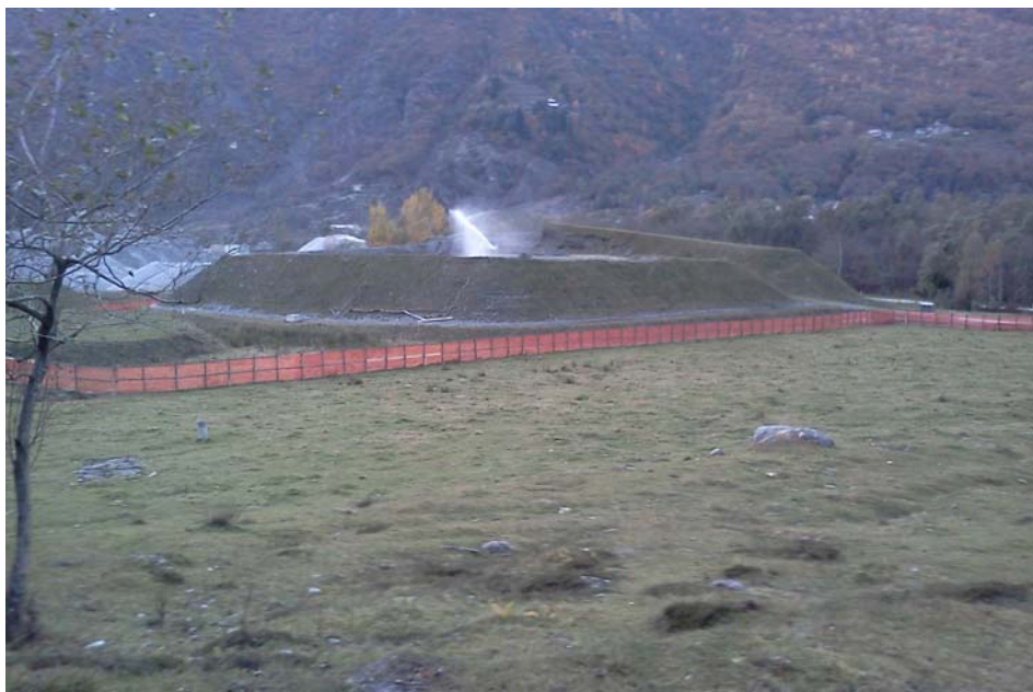
L'area di deposito vista dal lato a Nord.
