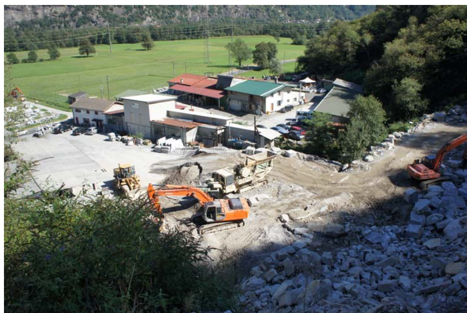
Attuale accesso, già adatto per il transito di mezzi pesanti.
