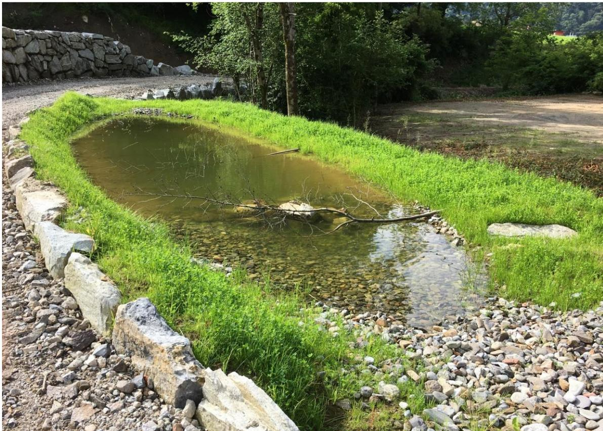
Figura 6-3: esempio di zona umida realizzata nella fascia di rispetto del riale Pevereggia, quale misura di compenso per la realizzazione della vicina discarica per materiali inerti *Fonderia 1*.
