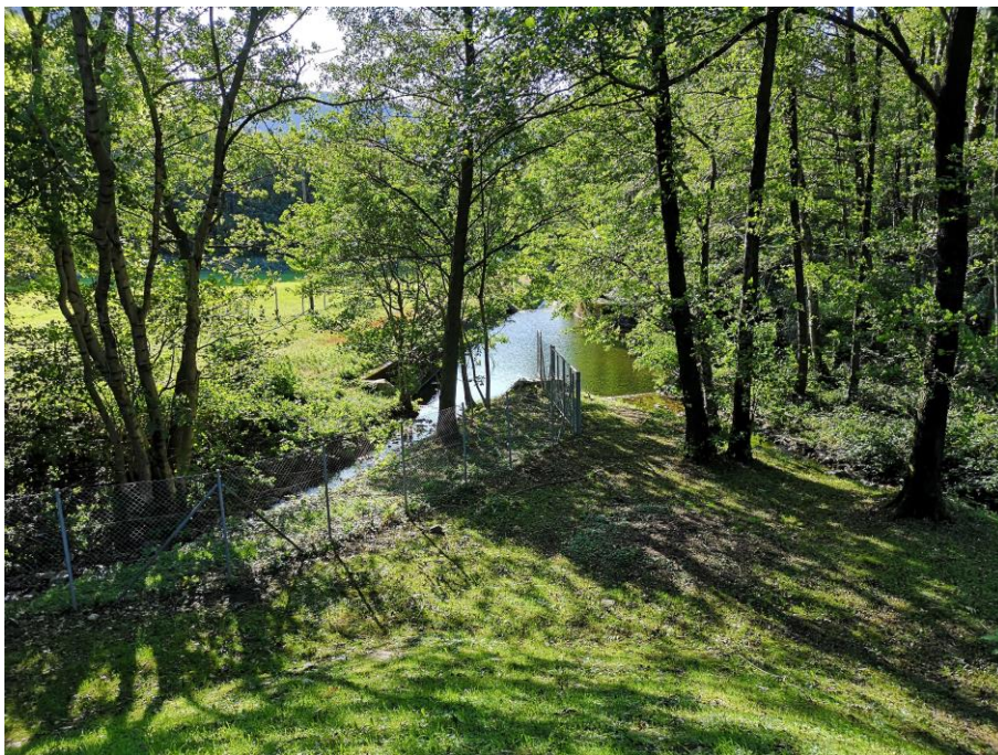
Figura 52: vasca artificiale a valle con ampie possibilità di valorizzazione
