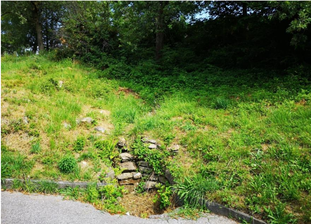
Figura 48: Riale centrale "Valécc de Mundáda"
