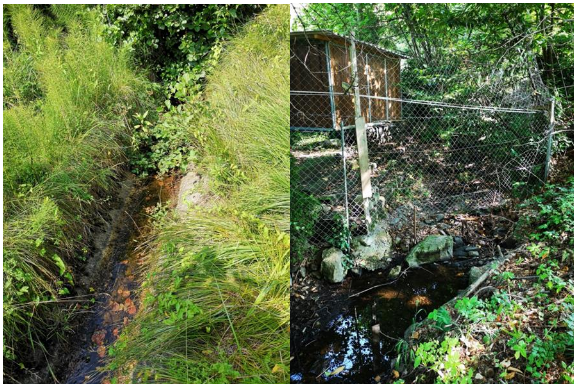
Figura 39: Tratto del Leguana in zona campo di calcio incanalato (sinistra) e strutture presenti lungo il riale (destra)
