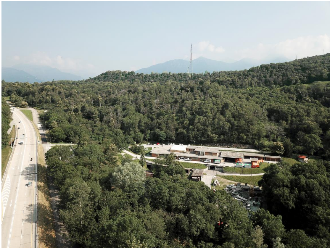
Figura 24. Discarica Monte Ceneri Est: stato di fatto
