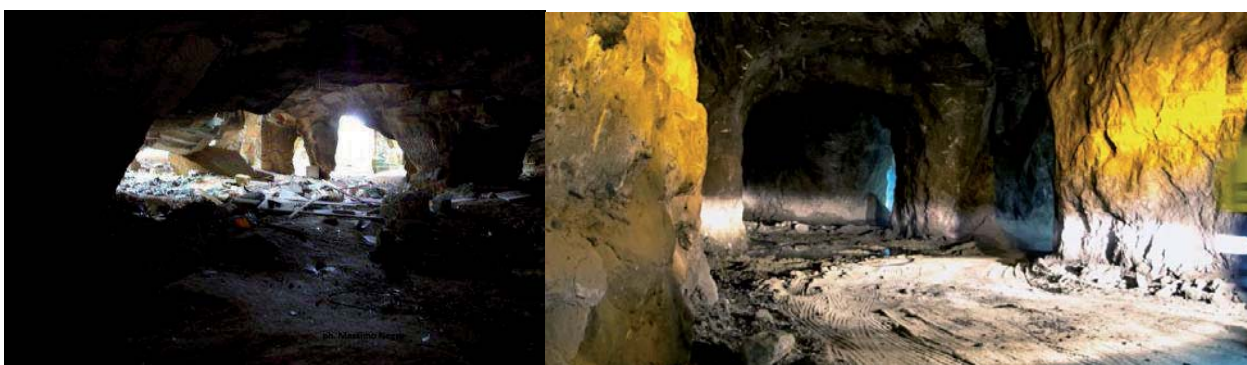
Immagine 10: A camere (a volta) e pilastri, a camere e pilastri per incroci di cunicoli di carreggio
