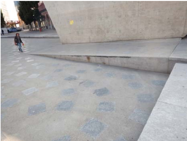
Fig. 11: Pavimentazione e rampa di accesso
