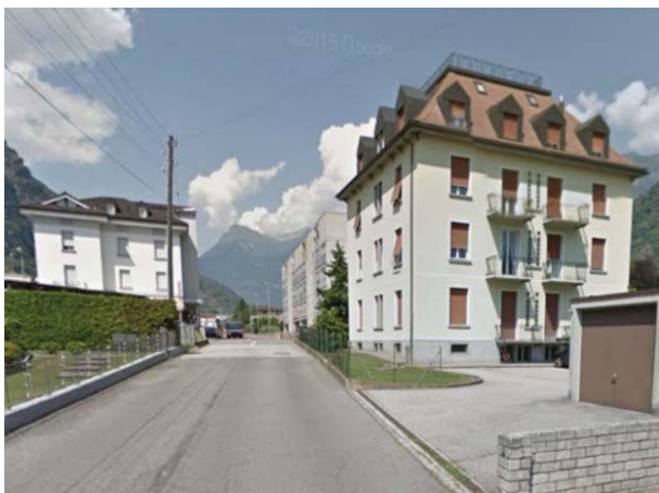
Fig. 8: Fronte strada di quartiere
