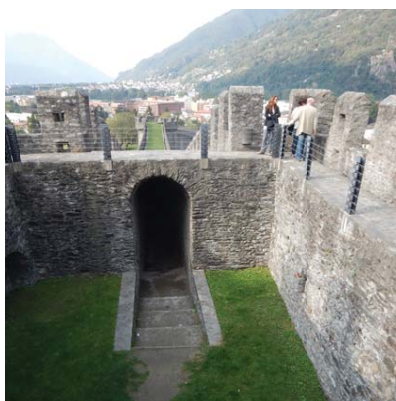
Fig. 5: Collegamento pedonale: accesso sotterraneo e in superficie alla via murata
