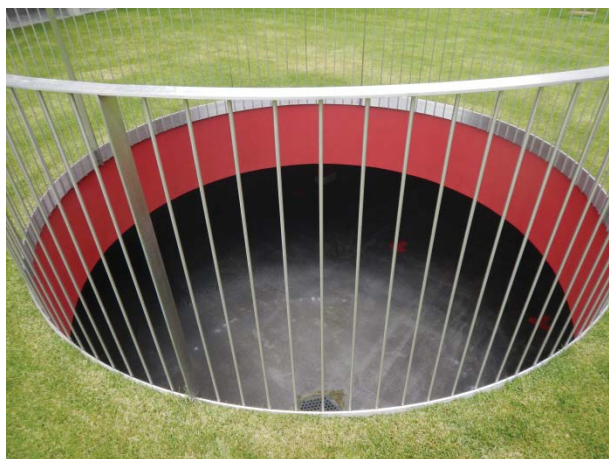
Fig. 9: Pozzo luce dell'autorimessa
