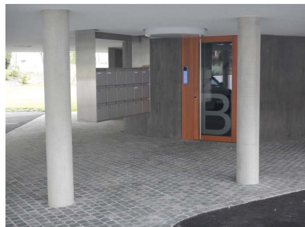
Fig. 10: Ingressi al PT
