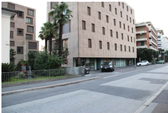
Fig. 4: Entrata da Via Varenna
