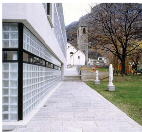
Fig. 4: Pavimentazione e facciata
