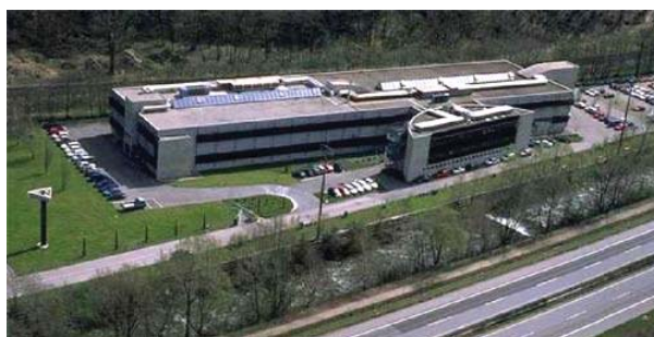
Fig. 5: Esempio di parcheggio esterno e spazi verdi
