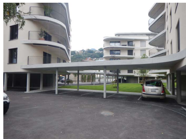
Fig. 8: Posteggi e porticati
