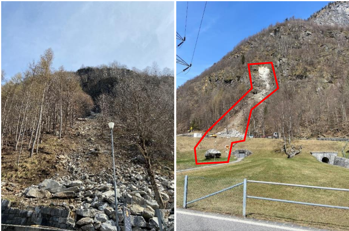
Figura 3-24: Crollo. Foto del 12.04.2022.
