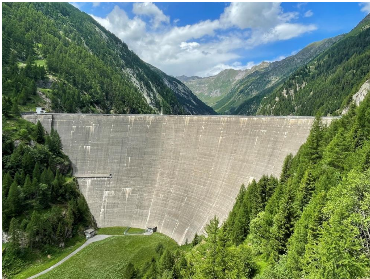
Figura 3-2: Fotografia della diga del Sambuco. Foto del 13.06.2022.
