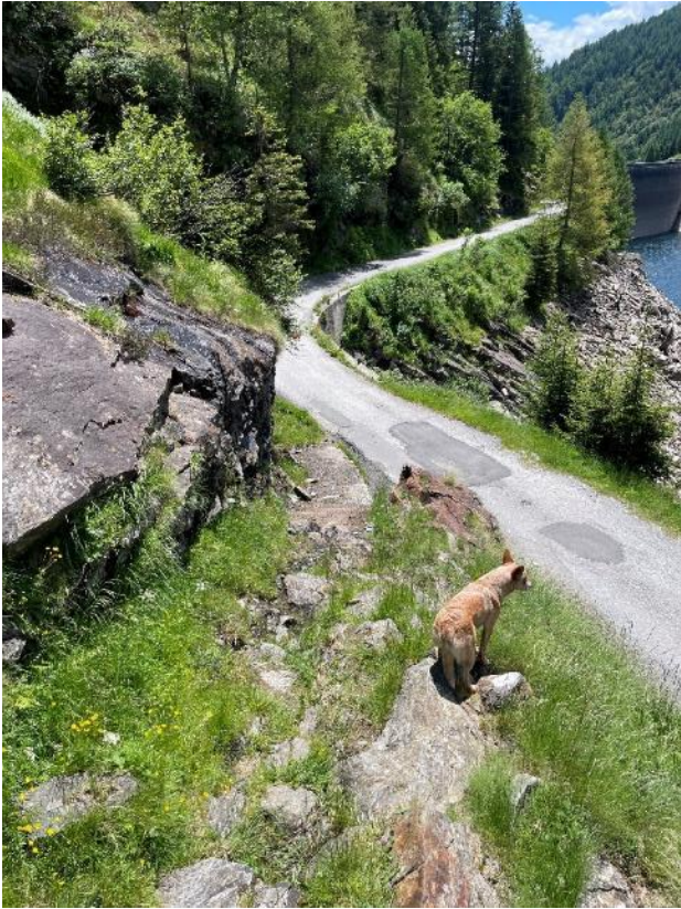
Figura 4-12: Imbocco via storica d'importanza regionale con molta sostanza.
