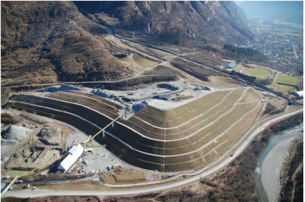
Figura 7 Vista dall'alto del deposito ATG (2011)
