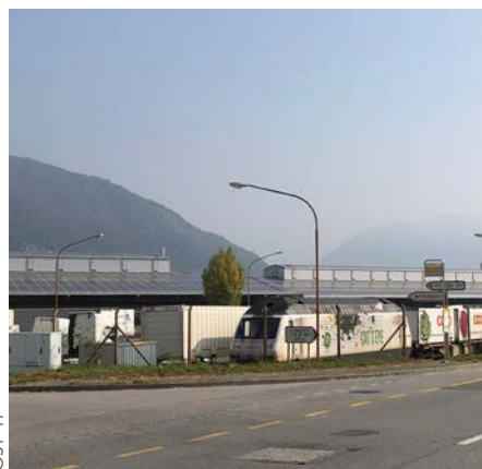
Magazzini logistici alla stazione di Chiasso
