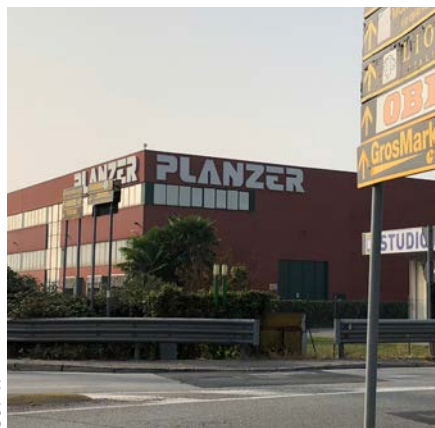
Stabilimento logistico a Montano Lucino (CO) di un'impresa svizzera
