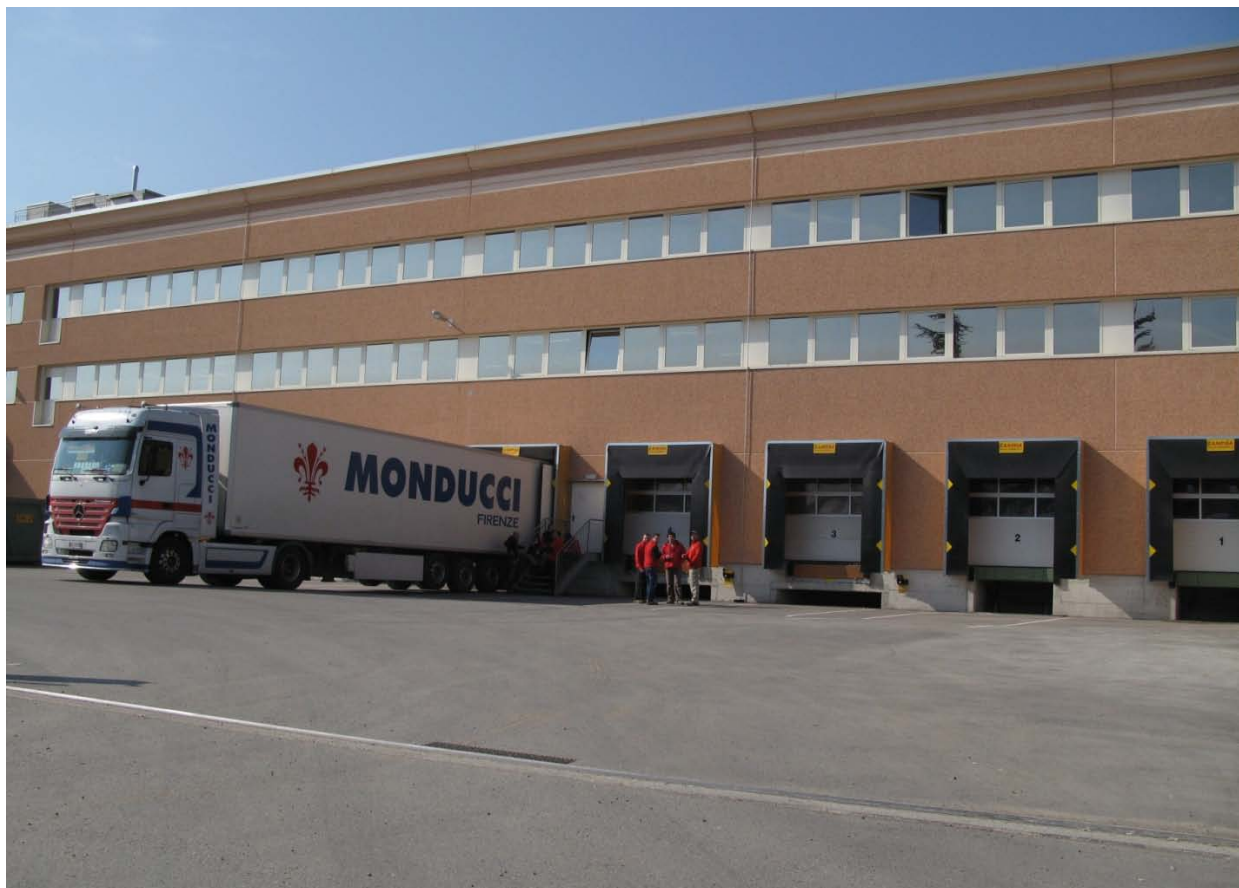
Insediamiento logistico nell'area di attività di Stabio (Foto: OST-TI, Aprile 2011).
