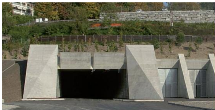
Il cunicolo di sicurezza.
