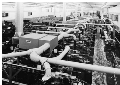
Sistema di aspirazione che permette di riciclare nel locale di lavoro l'aria aspirata e depurata o di evacuarla all'esterno.
