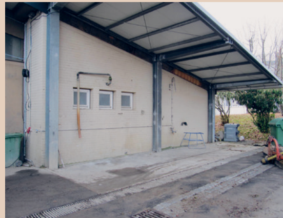
Area attrezzata per il riempimento dell'irroratrice, munita di braccio mobile per l'acqua e di griglie di drenaggio a Bavendorf (D), B. Arnold
