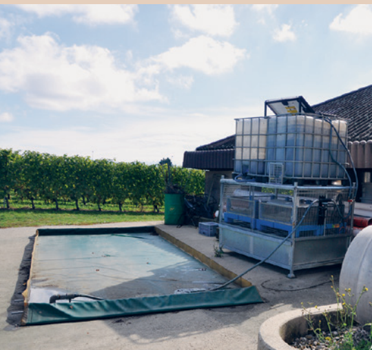
Piscinetta mobile per il lavaggio, con sistema Osmofilm, presso il centro di formazione Marcelin, M. Hochstrasser
