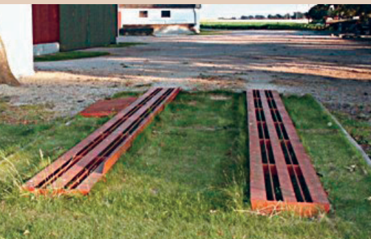
Il sistema Biobed è direttamente accessibile con il veicolo. Non occorre un'area attrezzata appositamente per il riempimento e il lavaggio, M. Castillo
