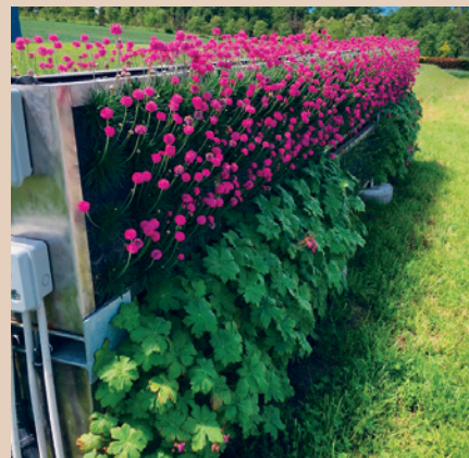
Il sistema Vertical Green Biobed™ occupa una superficie ridotta. Qui un impianto a Bernex, ecaVert
