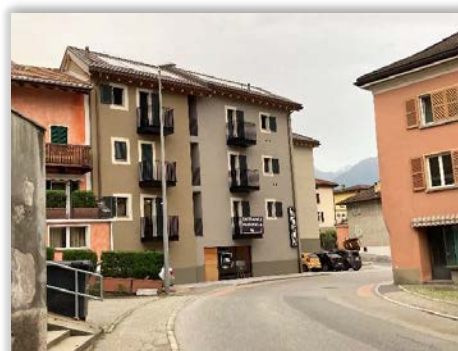
Interventi sicurezza a Lumino
