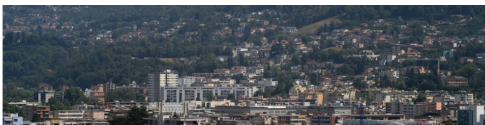
La diffusione del costruito lungo le pendici della valle del Cassarate
