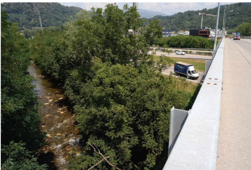
Panoramica dal viadotto di via Vedeggio
