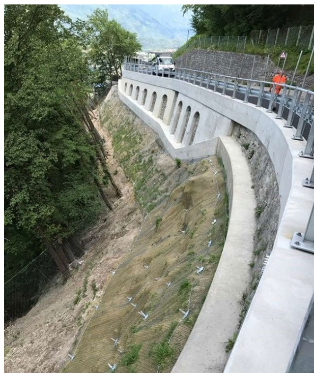
Esempio di allargamento puntuale della carreggiata
