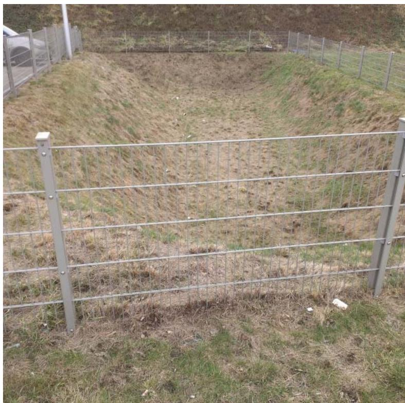
Figura 14: bacino di ritenzione e infiltrazione.
