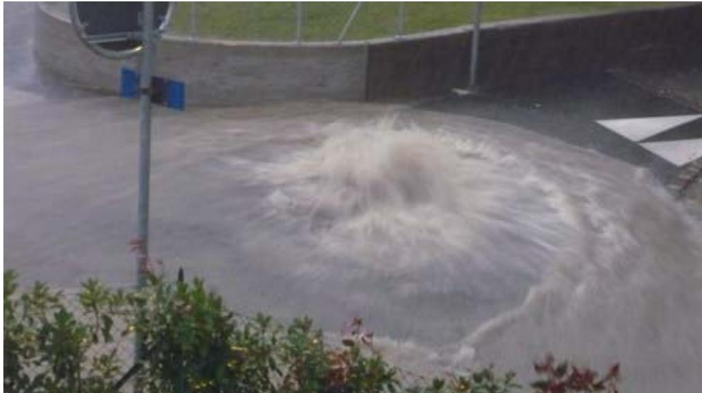
Figura I: esempio di sovraccarico idraulico di una canalizzazione.
