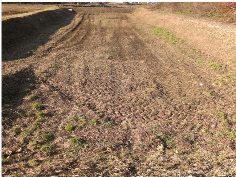
Figura 31: bacino di ritenzione e infiltrazione dove è stato utilizzato un mezzo non idoneo (costipamento).
