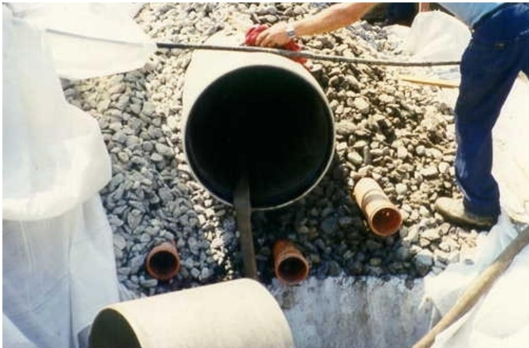
Figura 18: esempio di ritenzione-infiltrazione tramite canale di accumulo (collegato a PP) e trincea.
