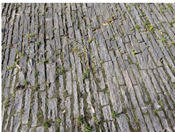
Figura 8: esempi di pavimentazione semi-permeabile in pietra.
