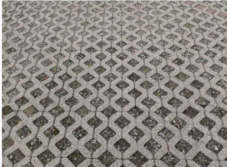
Figura 9: esempi di pavimentazione in ghiaia / grigliato con ghiaia (parcheggio).
