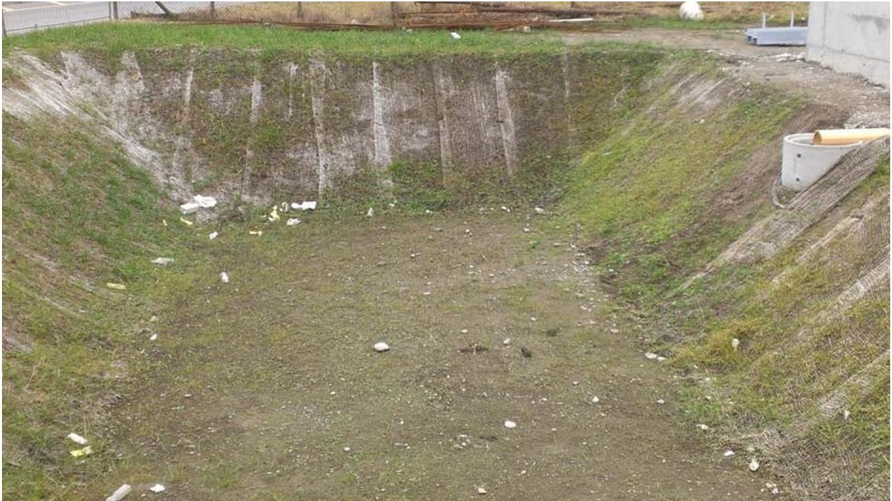
Figura 7: esempio di impianto di ritenzione e infiltrazione di recente costruzione.
